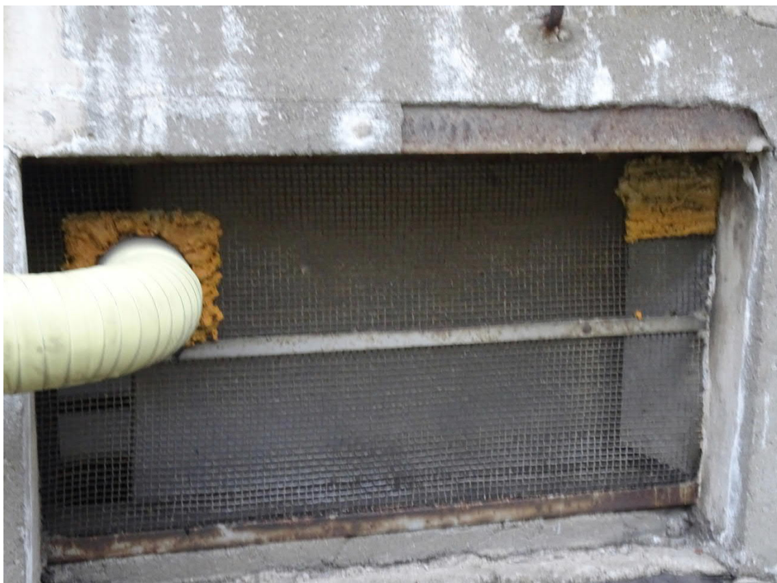
Abb. 4 Ausgeschäumte Öffnungen an Lüftungseinlass
