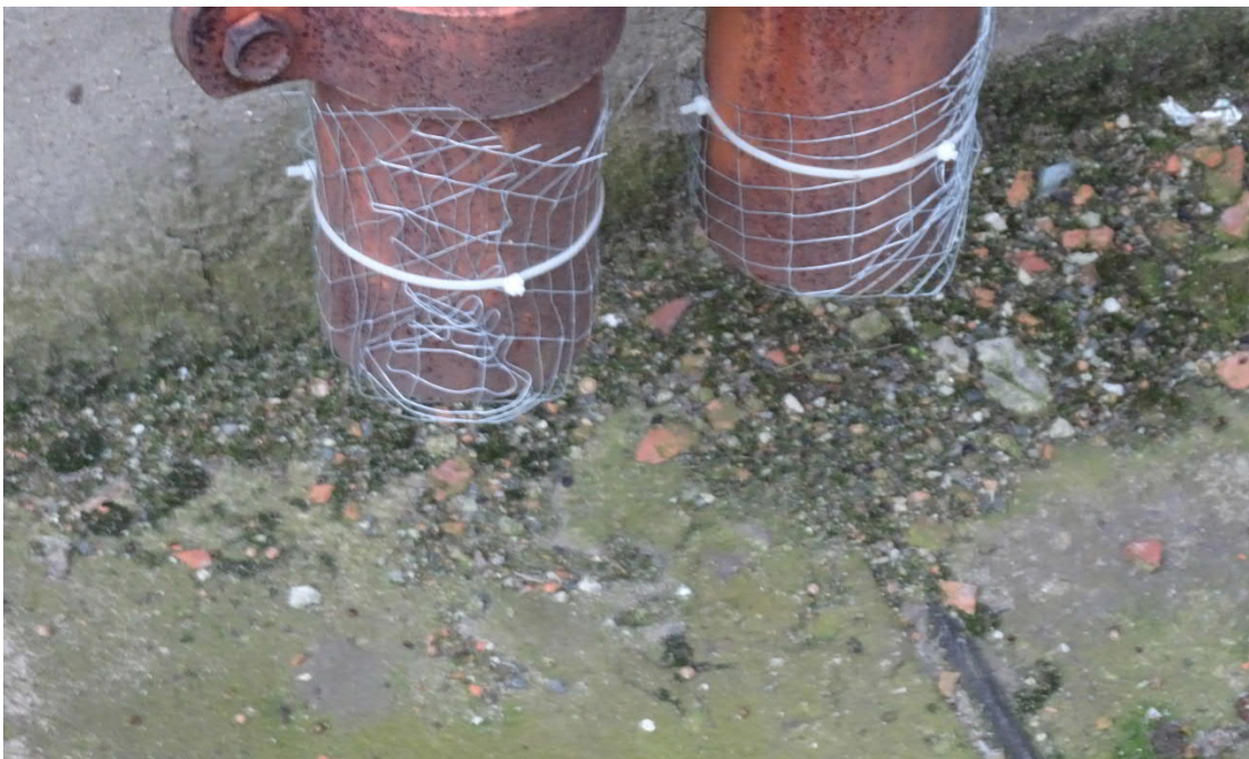
Abb. 6 Verschlussene Lüftungsrohre
