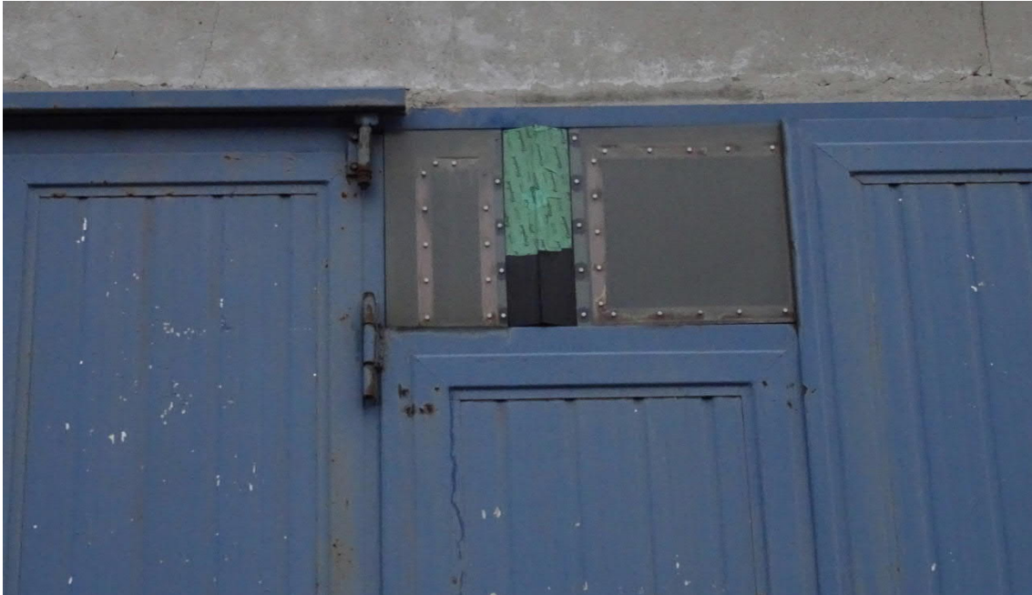
Abb. 1 Verschlussene Öffnung der ehemaligen Oberleitungszuführung
