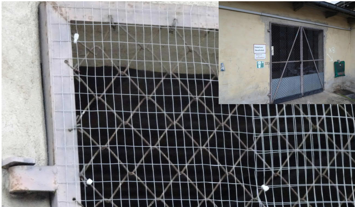
Abb. 3 Mit Estrichmatten gesicherter Verschlag
