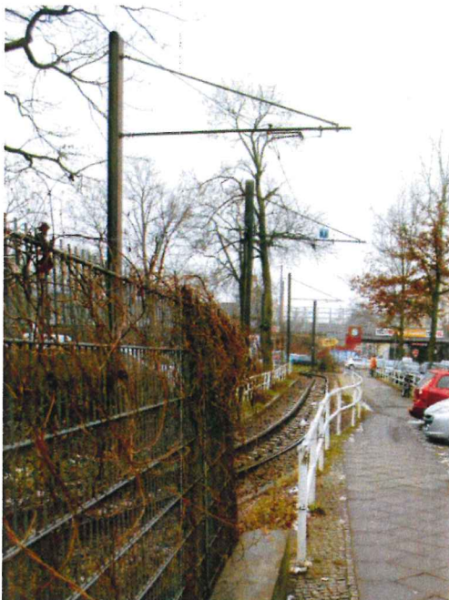
Abb. 10: vorhandene Fahrleitungsmaste
