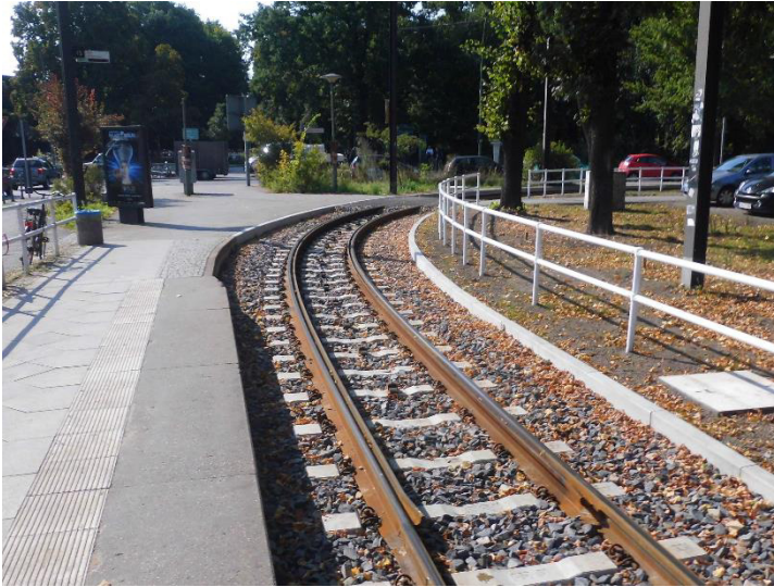
Abb. 8: offenes Querschellengleis, Aufnahme nach Fertigstellung 2014
