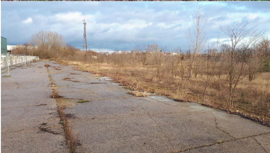
Abb. 12: Betonstraße, die im westlichen Bereich entlang der Grundstücksgrenze zur Firma Atos Information Technology GmbH verläuft
