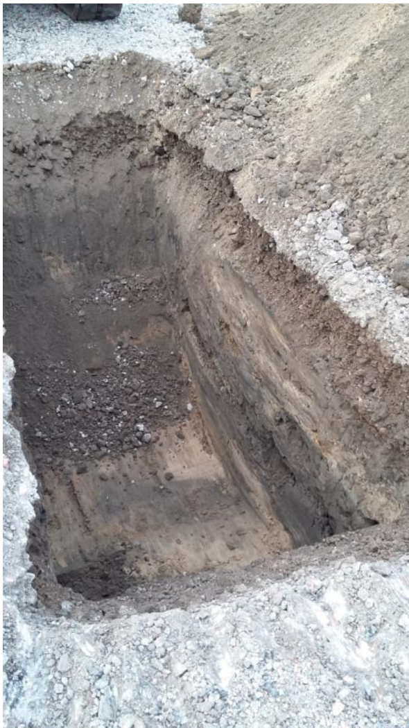
Abb. 14: Baggerschurf 1, Mächtigkeit Beton-RC-Material ca. 0,3 m, deutlich verdichtet, darunter anthropogene Auffüllung
