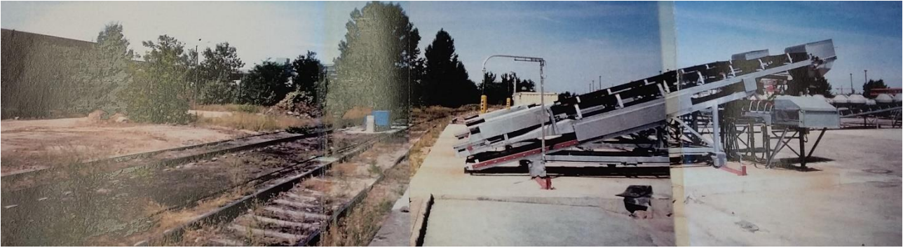
Abb. 2: Blick auf die Ladestraße II mit Förderanlage des ehemaligen Kohlebahnhofs Adlershof vom 04.10.1995, Blick Richtung Norden (Quelle: /12/)
