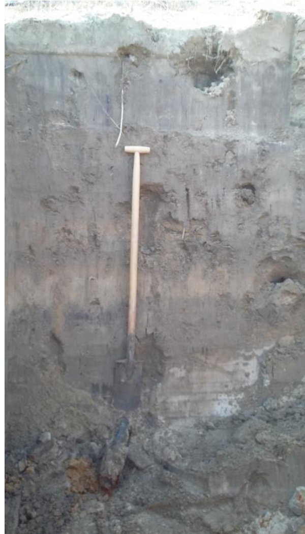
Abb. 21: Baggerschurf 8, Leitung Altbestand in ca. 1,8 m u. GOK (Verlauf wahrscheinlich Ost-West- Richtung, dem IBD liegt kein Leitungsplan vor, der diese Leitung beinhaltet)
