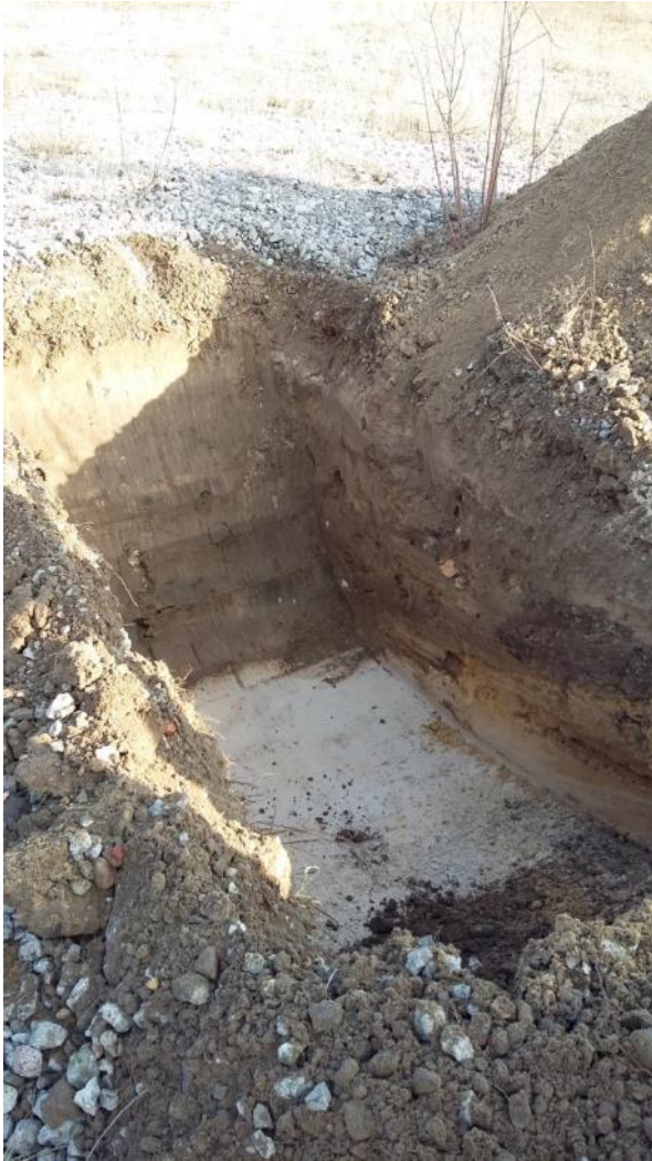
Abb. 20: Baggerschurf 7, Schotterstraße südliches Baufeld (Mächtigkeit Schotter ca. 0,4 m), heller Sandboden ab ca. 1,0 m u. GOK
