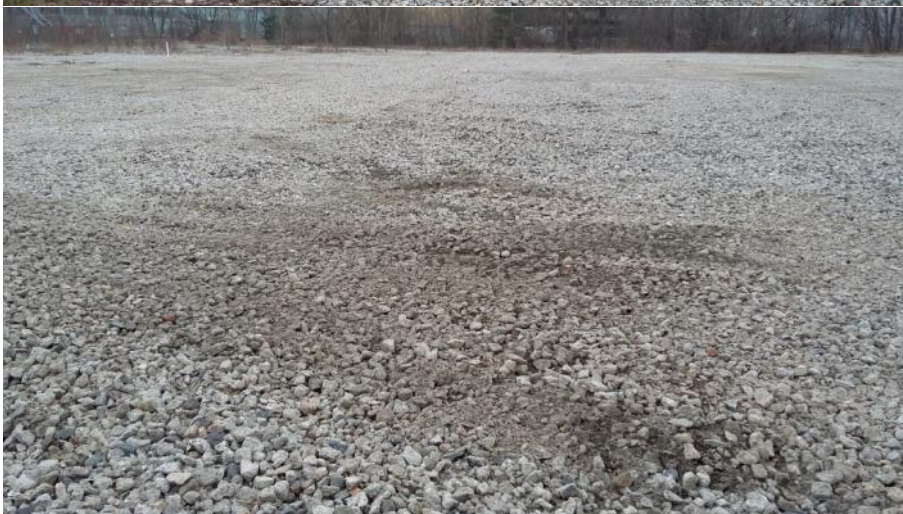
Abb. 3: Beton-RC-Material liegt großflächig im mittleren und nördlichen Bereich aus
