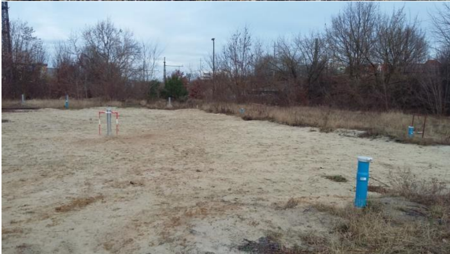
Abb. 6: Teil der Kontaminationsfläche „KF 1005-004“ nach erfolgter Boden- Quellherdsanierung 2017 (Austausch Boden gegen Füllboden Z 0) mit den Brunnen/ Grundwassermess- stellen
