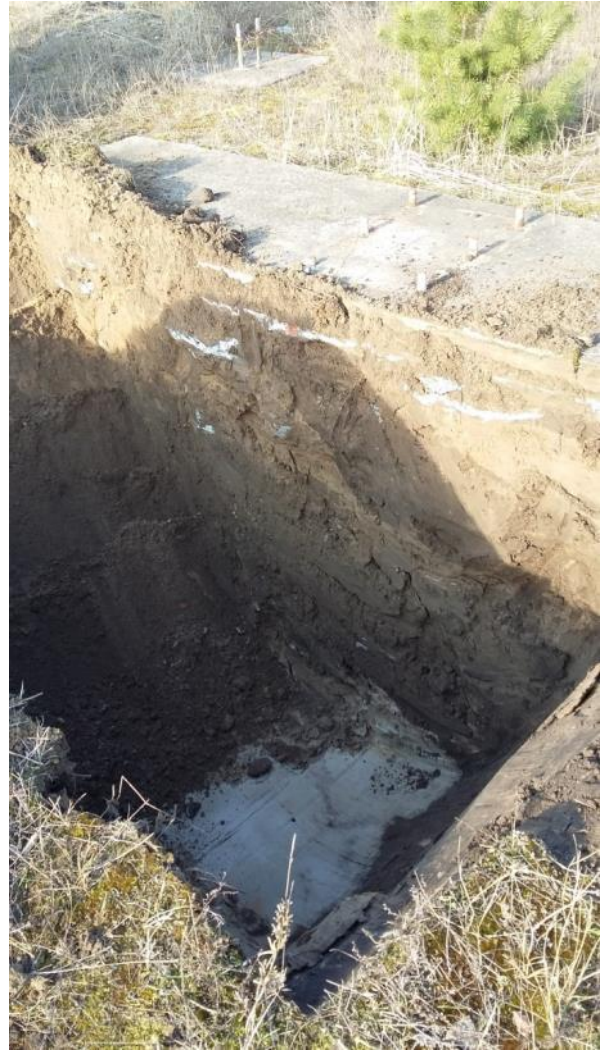
Abb. 19: Baggerschurf 6 neben Betonfundament, Mächtigkeit 0,8 – 1,2 m. Ab ca. 2,0 m u. GOK heller Sandboden.
