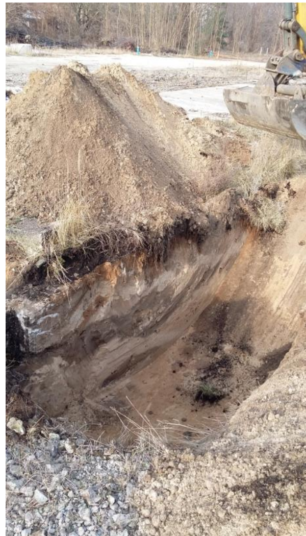
Abb. 15: Baggerschurf 2, Mächtigkeit Betonstraße nördlich des RC-Materials ca. 0,8 m
