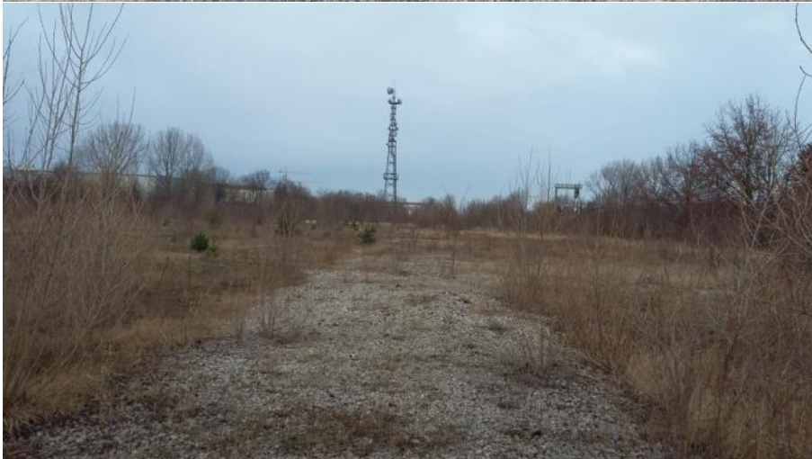
Abb. 9: Schotterstraße (Mächtigkeit ca. 0,4 m) im Süden des Grundstücks (Blick Richtung Norden)
