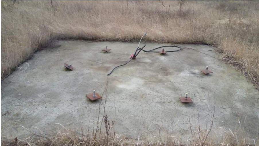
Abb. 10: Fundamente aus Beton, Reste der Solaranlagen der Fa. Solon AG
