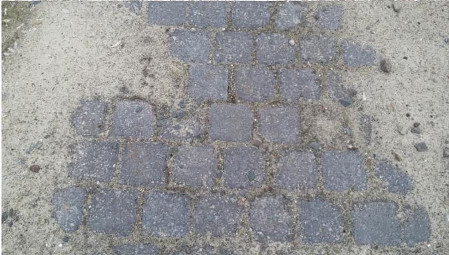
Abb. 8: Straße aus Schlackesteinen südlich der Sanierungsfläche
