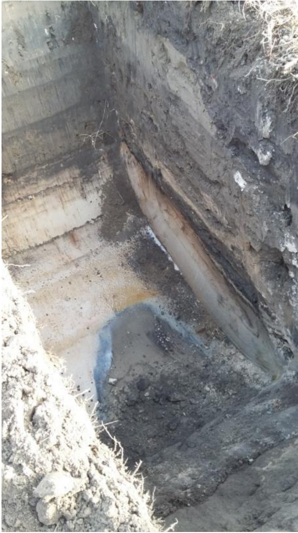
Abb. 18: Baggerschurf 5, verschiedene Bodenschichten, Benetzung der Sohle mit Wasser in ca. 1,80 m u. GOK
