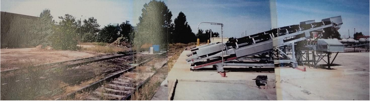
Abb. 2: Blick auf die Ladestraße II mit Förderanlage des ehemaligen Kohlebahnhofs Adlershof vom 04.10.1995, Blick Richtung Norden (Quelle: /12/)
