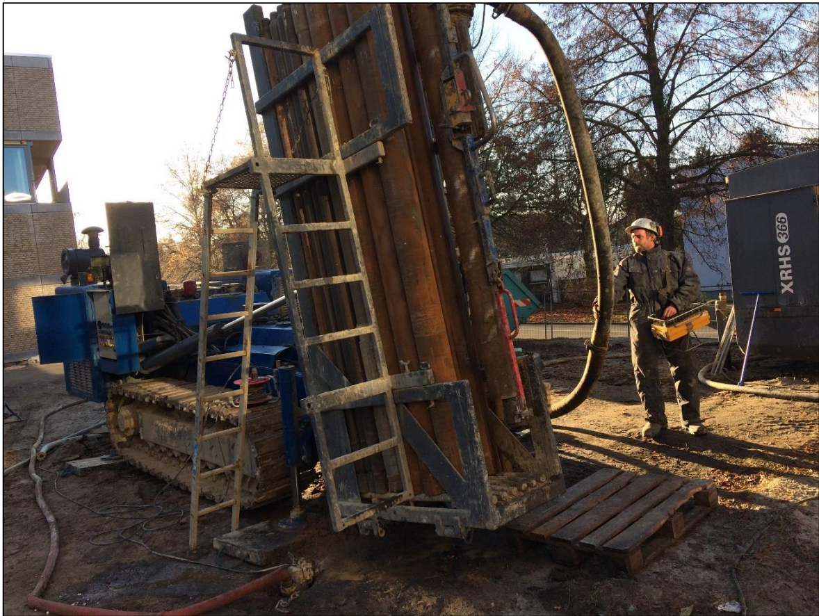
Abbildung 3-1: Herstellung einer Erdwärmesonde mittels Raupenbohrgerät in Wolfsburg [H.S.W. GmbH]
