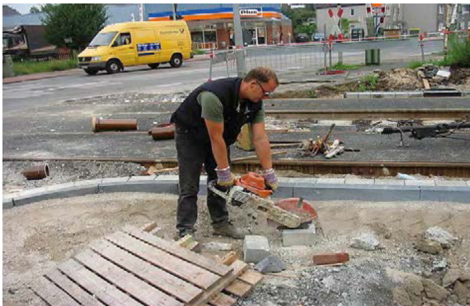
Steine werden zum Verlegen mit Diamantsägeblatt freihändig geschnitten (aus [11], Anlage E 117, Seite 252 f)
