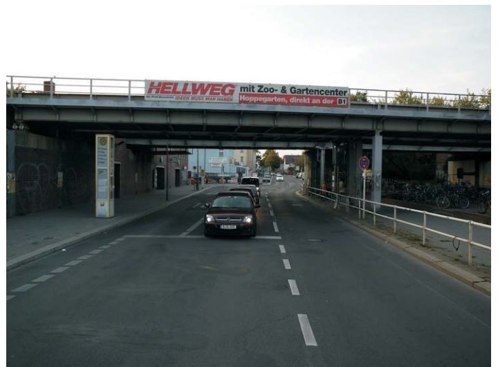
Knoten Hönowe Straße - Treskowstraße Blickrichtung: Bhf. Mahlsdorf Bild 1
