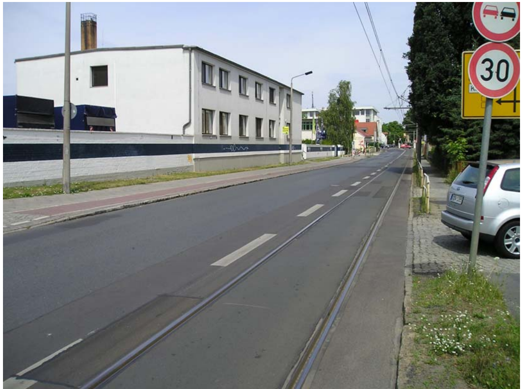
Hultschiner Damm, Blickrichtung Nord
