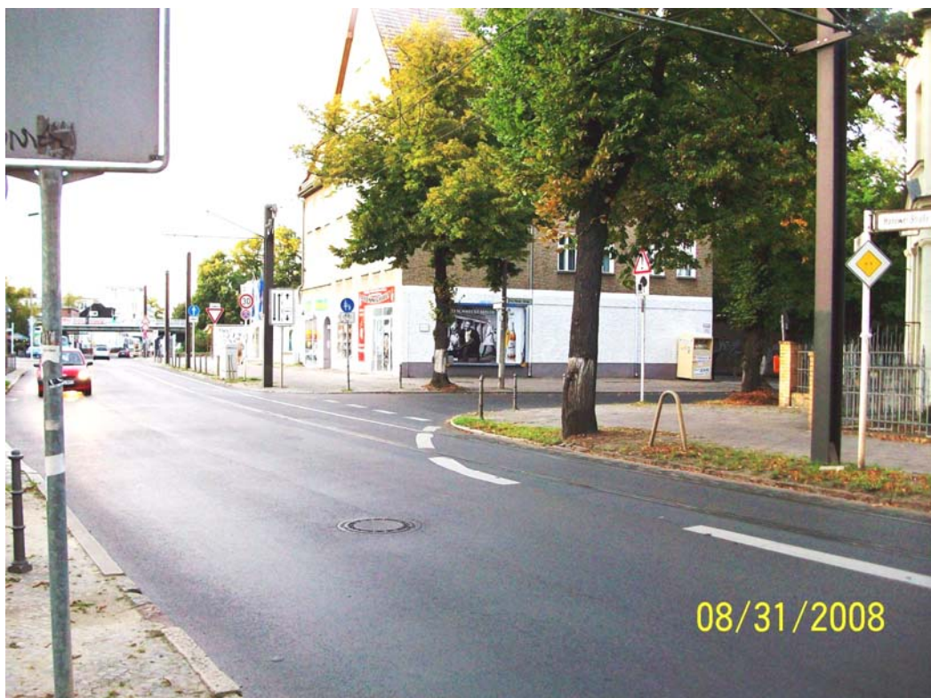
Höninger Straße, Einmündung Fritz-Reuter-Straße, Blickrichtung Nord
