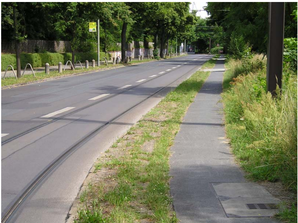
Hultschiner Damm, Blickrichtung Nord
