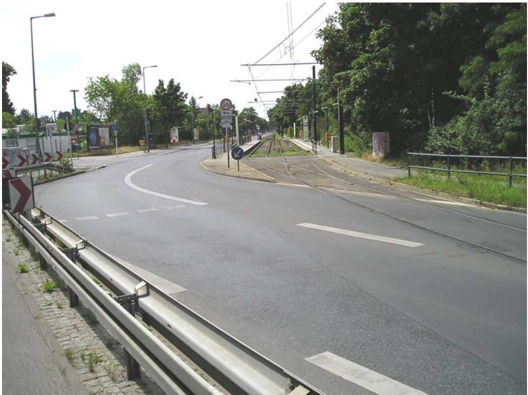
Hultschiner Damm, Haltestelle Rahnsdorfer Straße, Blickrichtung Süd
