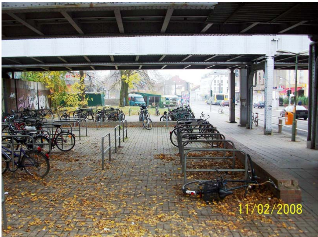
Höninger Straße, freies Brückenfeld unterhalb der Bahnbrücke Bahnhof Mahlsdorf, Blickrichtung Süd
