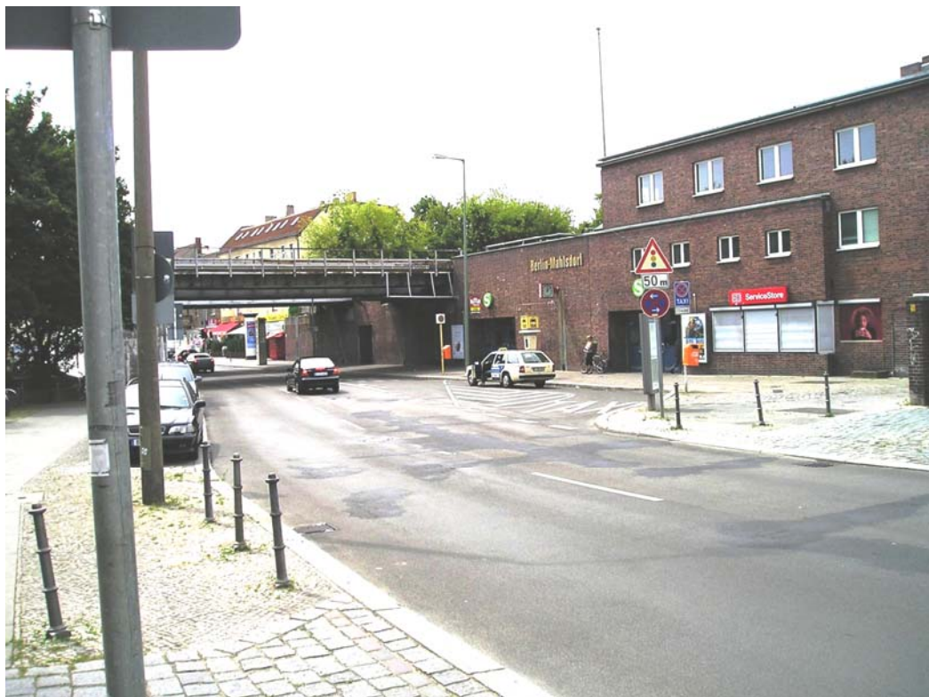
Höninger Straße, Bahnhof Mahlsdorf mit Bushaltestelle, Blickrichtung Süd
