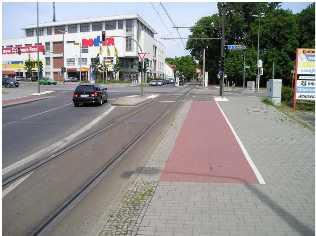
Hultschiner Damm, Kreuzung Alt Mahlsdorf (B1/B5), Blickrichtung Nord
