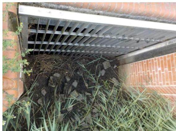
Abb. 2-14: Auslaufbauwerk aus dem Elsteich bei Stat. Km 0+750 (UBB 2020).
