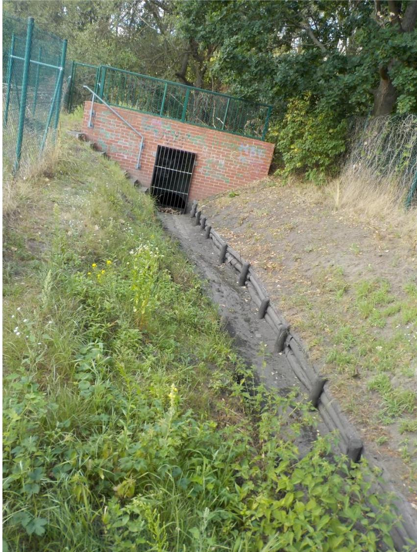
Abb. 2-15: Offener Grabenabschnitt und Auslaufbauwerk zu den Vorgewässern des Elsensees bei Stat. Km 0+135 (UBB 2020).
