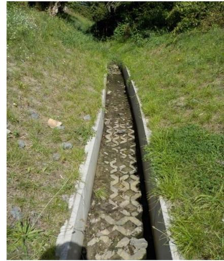
Abb. 2-9: Durch Sohlen- und Uferverbau geprägter Grabenabschnitt bei Stat. Km 1+100 (UBB 2020).
