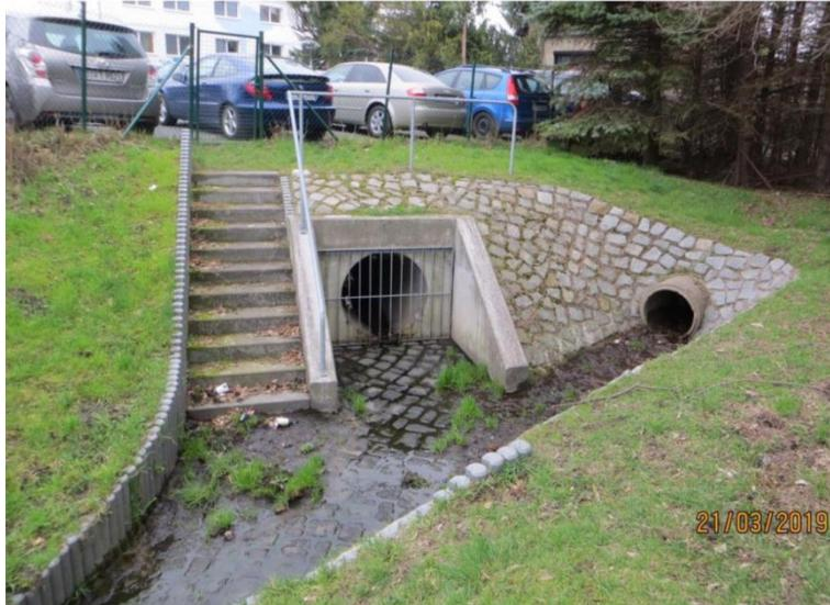
Abb. 2-5: Auslaufbauwerk (rechts) und RW-Einleitung ALBA (links) südlich der B1/B5 bei Stat. Km 1+275 (PLANLAND 2019).
