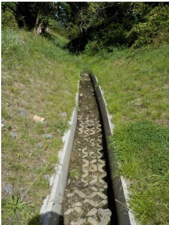
Abb. 4-1: Durch Sohlen- und Uferverbau geprägter Grabenabschnitt bei Stat. Km 1+100 (UBB 2020).
