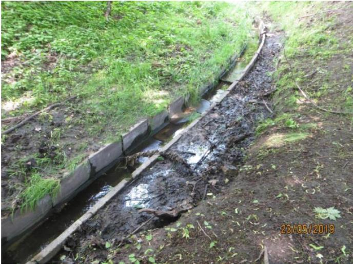
Abb. 2-8: Durch Sohlen- und Uferverbau geprägter Grabenabschnitt bei Stat. Km 1+150 (PLANLAND 2019).
