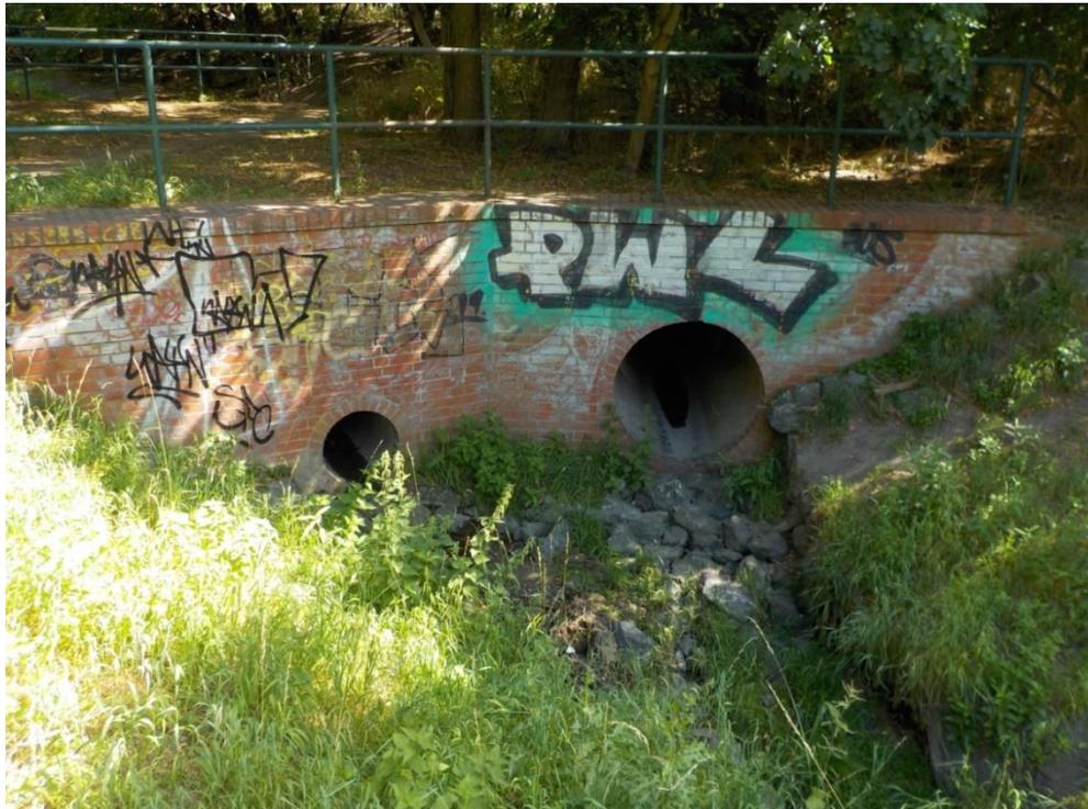
Abb. 2-10: Durchlassbauwerk (links) und Regenwassereinleitung (rechts) bei Stat. Km 1+020 (UBB 2020).
