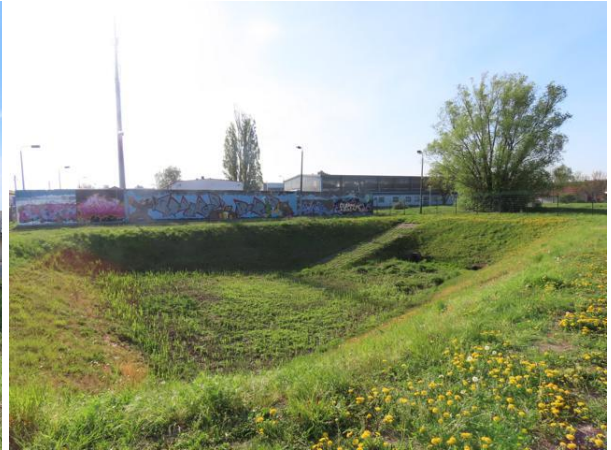
Abb. 15: Regenrückhaltebecken an der Straße „An der Schule“
