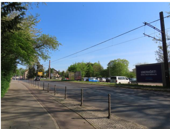
Abb. 6: Mittlerer Bereich des Hultschiner Damms (links im Bild ist der Gutspark Mahlsdorf)
