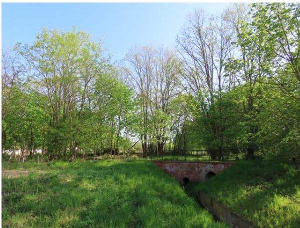
Abb. 4: Rohrpfuhlgraben Mahlsdorf – Blick nach Süden
