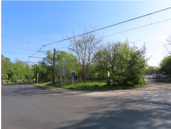
Abb. 2: Blick entlang des Hultschiner Damms - im Süden des Untersuchungskorridors
