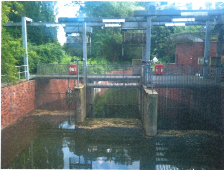
Abbildung 8: Rechenanlage Schulzendorfer Straße (Quelle: WECO)
