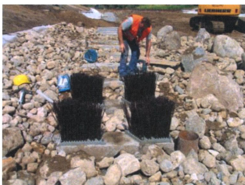
Abbildung 7: Beispiele für einen Borstenpass (Quelle: WECO)
