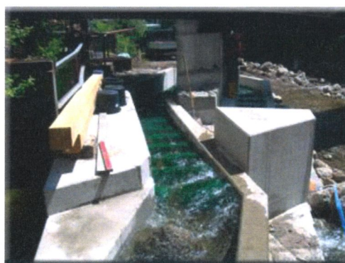
Abbildung 7: Beispiele für einen Borstenpass (Quelle: WECO)
