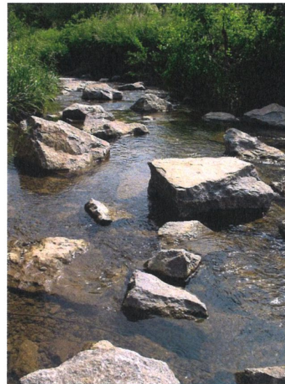
Abbildung 5: Beispiele für Störsteine im Wasserbau als Strukturelemente (Quelle: WECO)
