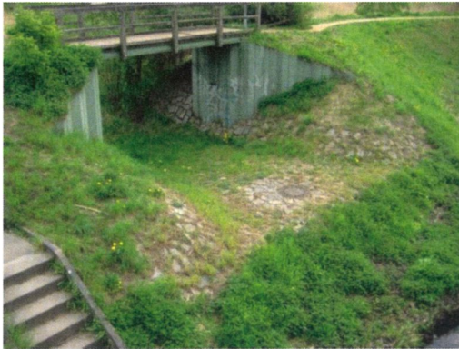
Abbildung 15: Becken am Bürgerpark, links: Einlaufbauwerk; rechts: Panke im Bereich des Beckens (Quelle: WECO)
