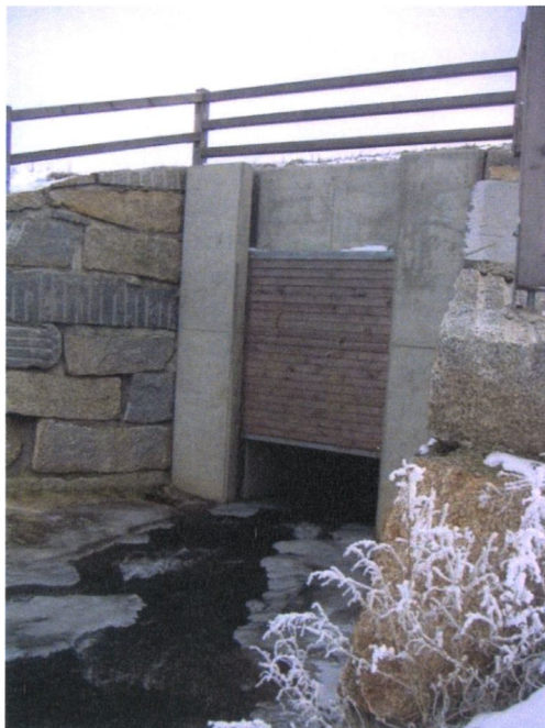
Abbildung 14: Beispiel für ein passierbares Auslaufbauwerk, links oberwasserseitige Ansicht mit beweglichem Schieber; rechts: unterwasserseitige Ansicht (Quelle: WECO)
