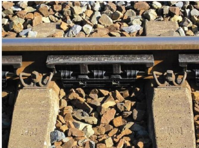
Bild 4: Beispielfoto für die Technologie Schienenstegdämpfer
