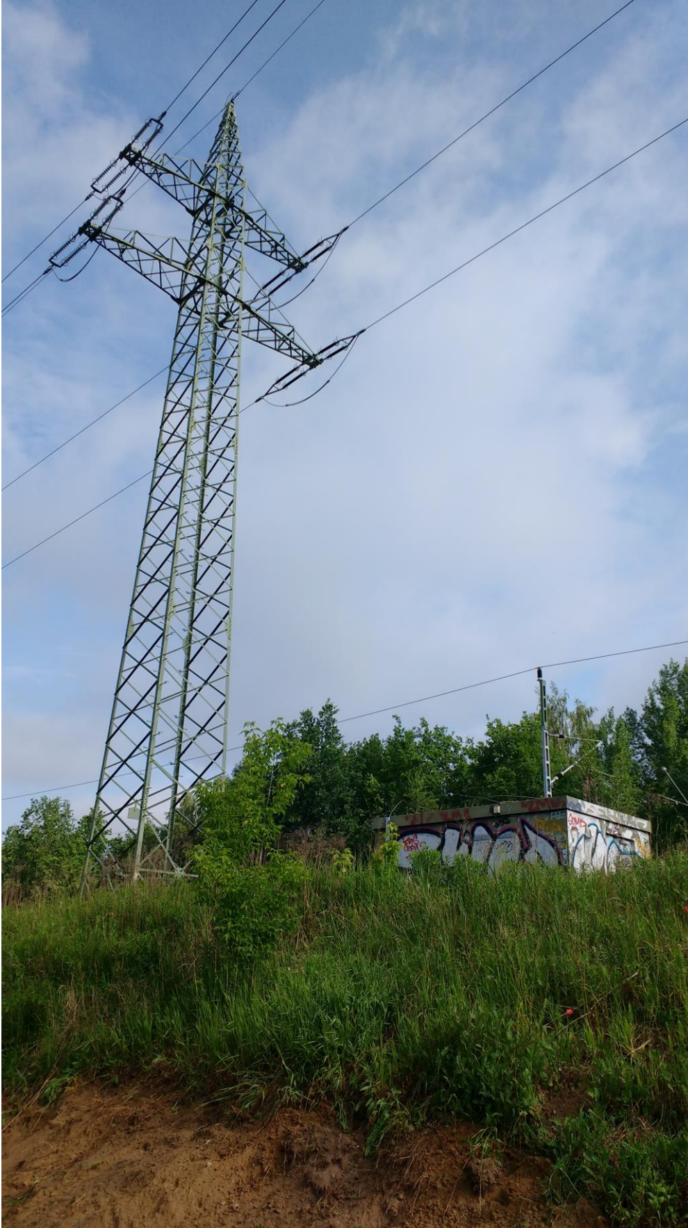
Hochspannungsmast mit Kolkrabennest, Rohbodenflächen als geeignete Eiablagefläche für Zauneidechsen
