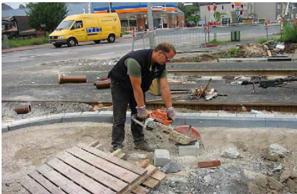
Steine werden zum Verlegen mit Diamantsägeblatt freihändig geschnitten (aus [11], Anlage E 117, Seite 252 f)
