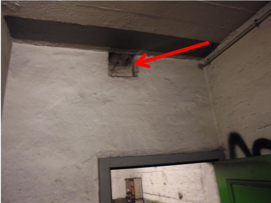
**Abb. 24:** Übersichtsaufnahme innerhalb des Raumes Nr. 101 mit Kennzeichnung von Wandöffnungen ohne Feuerwiderstand
