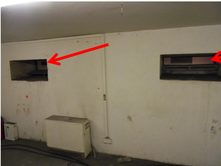
**Abb. 19:** Übersichtsaufnahme innerhalb des Raumes Nr. 251 mit Kennzeichnung der Verglasung ohne Feuerwiderstand
