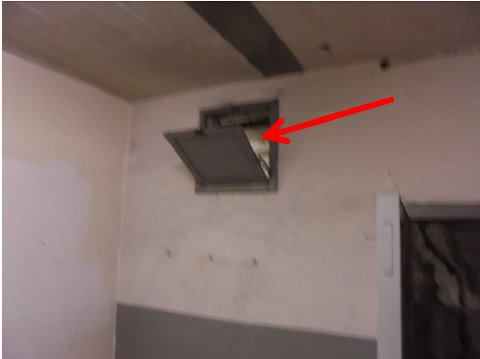
**Abb. 16:** Übersichtsaufnahme innerhalb des Raumes Nr. 105 mit Kennzeichnung der Lüftungsöffnung ohne Feuerwiderstand
