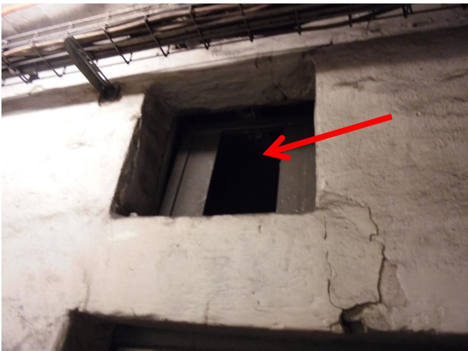
**Abb. 15:** Übersichtsaufnahme innerhalb des Raumes Nr. 104 mit Kennzeichnung der Lüftungsöffnung ohne Feuerwiderstand
