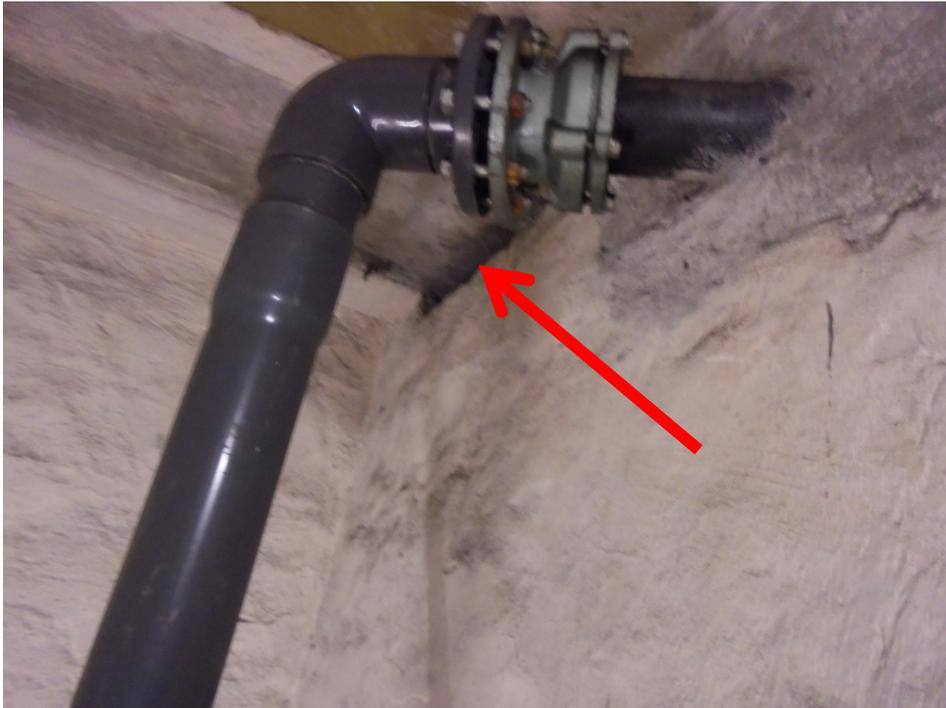
**Abb. 26:** Übersichtsaufnahme innerhalb des Raumes Nr. 102 mit Kennzeichnung von Wandöffnungen ohne Feuerwiderstand
