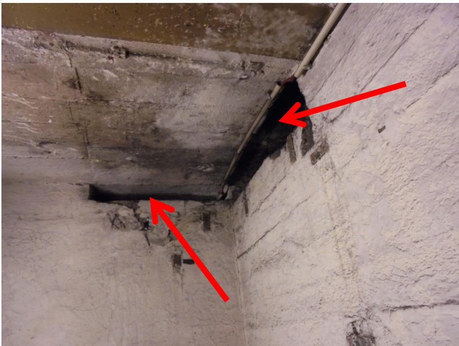
**Abb. 23:** Übersichtsaufnahme innerhalb des Raumes Nr. 101 mit Kennzeichnung von Wandöffnungen ohne Feuerwiderstand
