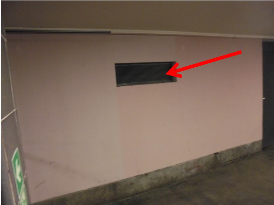
**Abb. 20:** Übersichtsaufnahme des Raumes Nr. 257 von außen mit Kennzeichnung der Verglasung ohne Feuerwiderstand
