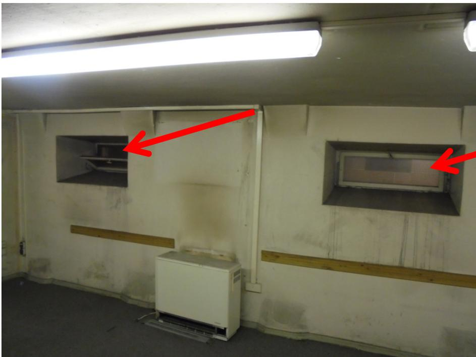
**Abb. 17:** Übersichtsaufnahme innerhalb des Raumes Nr. 152 mit Kennzeichnung der Verglasung ohne Feuerwiderstand
