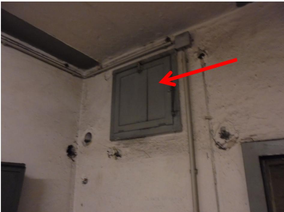
**Abb. 27:** Übersichtsaufnahme innerhalb des Raumes Nr. 103 mit Kennzeichnung von Wandöffnungen ohne Feuerwiderstand
