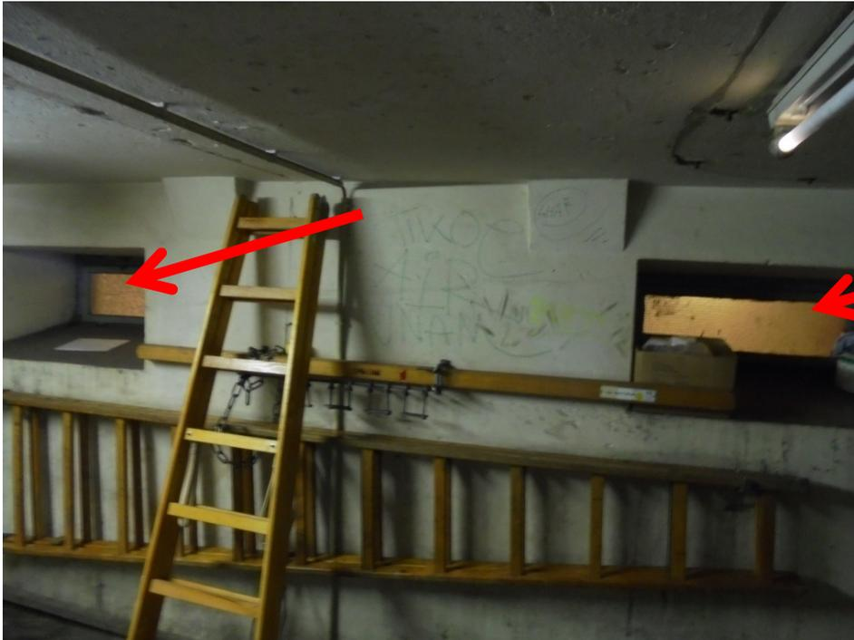
**Abb. 18:** Übersichtsaufnahme innerhalb des Raumes Nr. 160 mit Kennzeichnung der Verglasung ohne Feuerwiderstand
