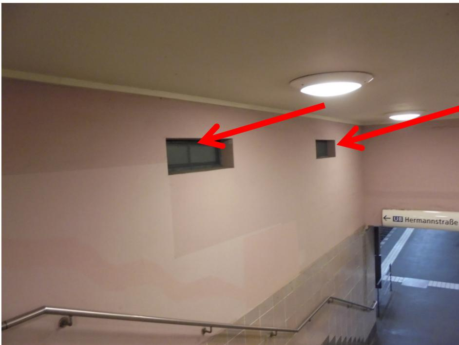
**Abb. 21:** Übersichtsaufnahme des Raumes Nr. 259 von außen mit Kennzeichnung der Verglasung ohne Feuerwiderstand
