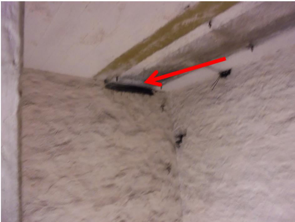
**Abb. 25:** Übersichtsaufnahme innerhalb des Raumes Nr. 102 mit Kennzeichnung von Wandöffnungen ohne Feuerwiderstand
