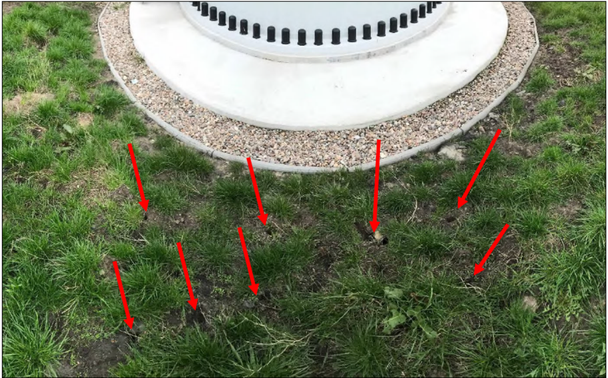
Abbildung 2 Mauselöcher im mit Moor- und Mineralboden angedeckten Mastfußbereich einer WEA
