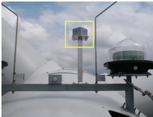
Abbildung 2: Oben auf der WEA-Gondel angebrachter Sensor (gelb hervorgehoben)
