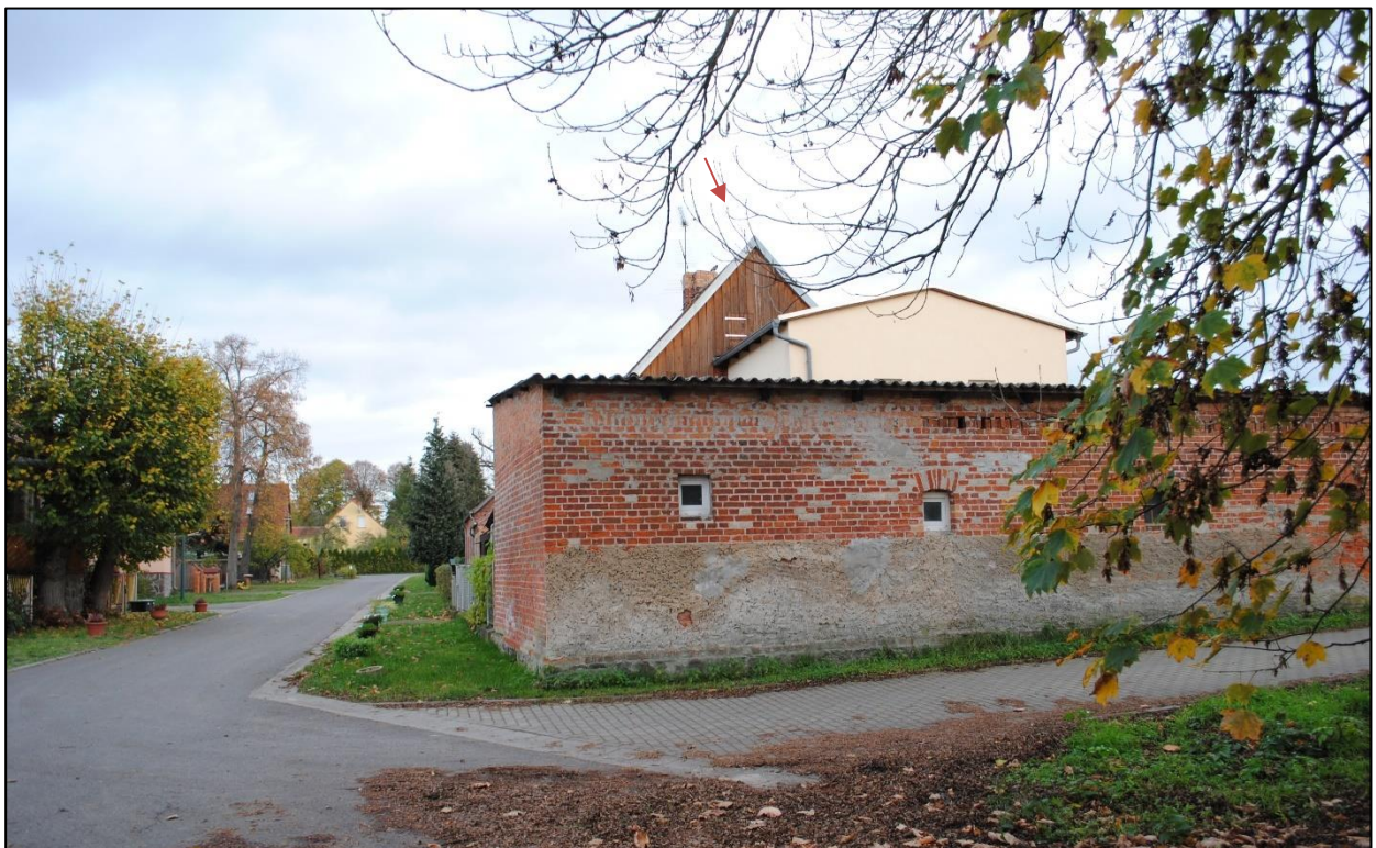
Abbildung 5: Blick nach Osten in Richtung WEA und auf den Dorfkrug (roter Pfeil)
