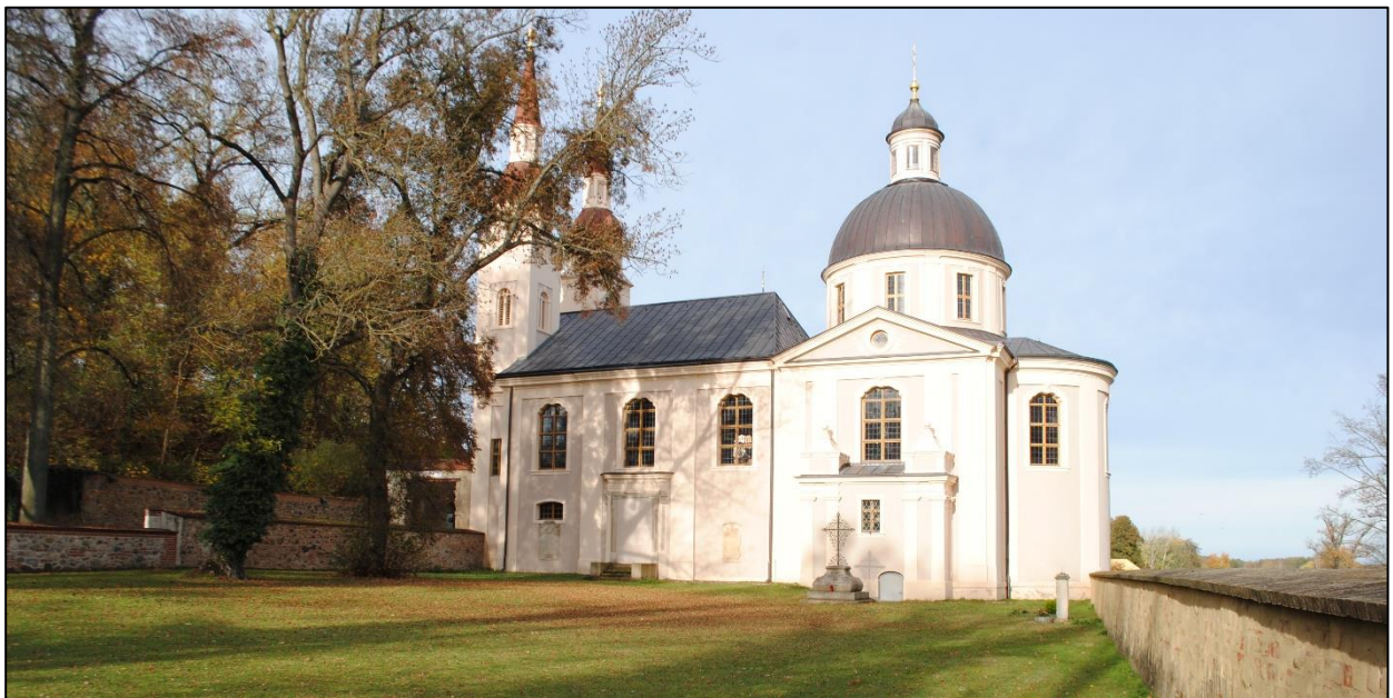
Abbildung 11: Pfarrkirche, Blick nach Nordwesten
