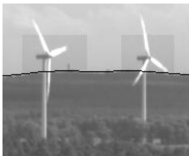
Abbildung 1: Automatisch generierte Ausschlussgebiete um die Rotoren von Windenergieanlagen.
