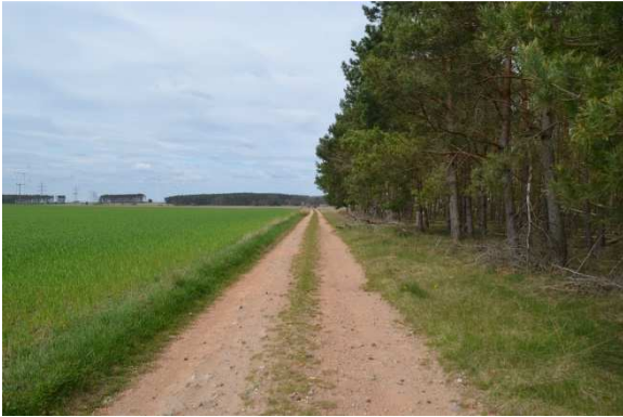
Abb. 37: Dauerhafte Zuwegung auf Bestandsweg bis zum Ende des Kiefernforstes, Fotostandort 139 nach NW
