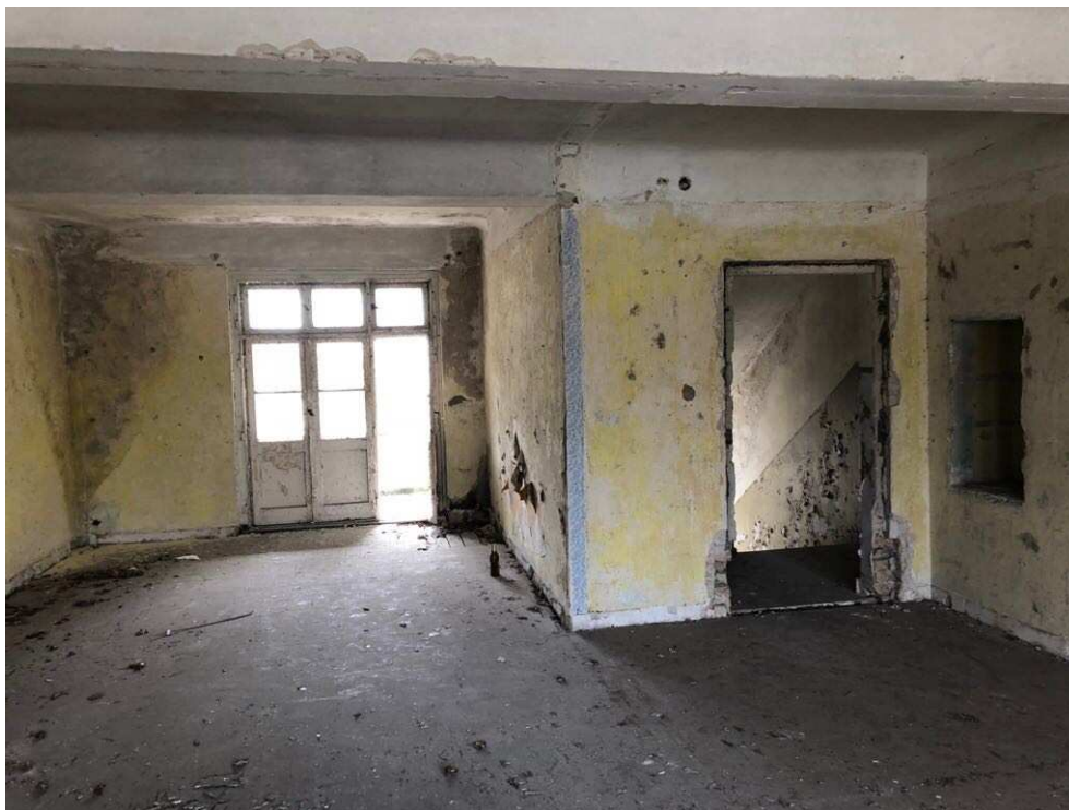
Abbildung 7: Raum im zentralen Obergeschoss mit Balkon auf der Südfassade. Das Vermauern der Fensteröffnungen dient der Neuschaffung von Quartierstrukturen, dem Fernhalten von Prädatoren aus dem Gebäudeinneren, der Abdunklung und Klimastabilisierung (Zugluft!) und somit der erheblichen Quartieroptimierung aller Innenräume.
