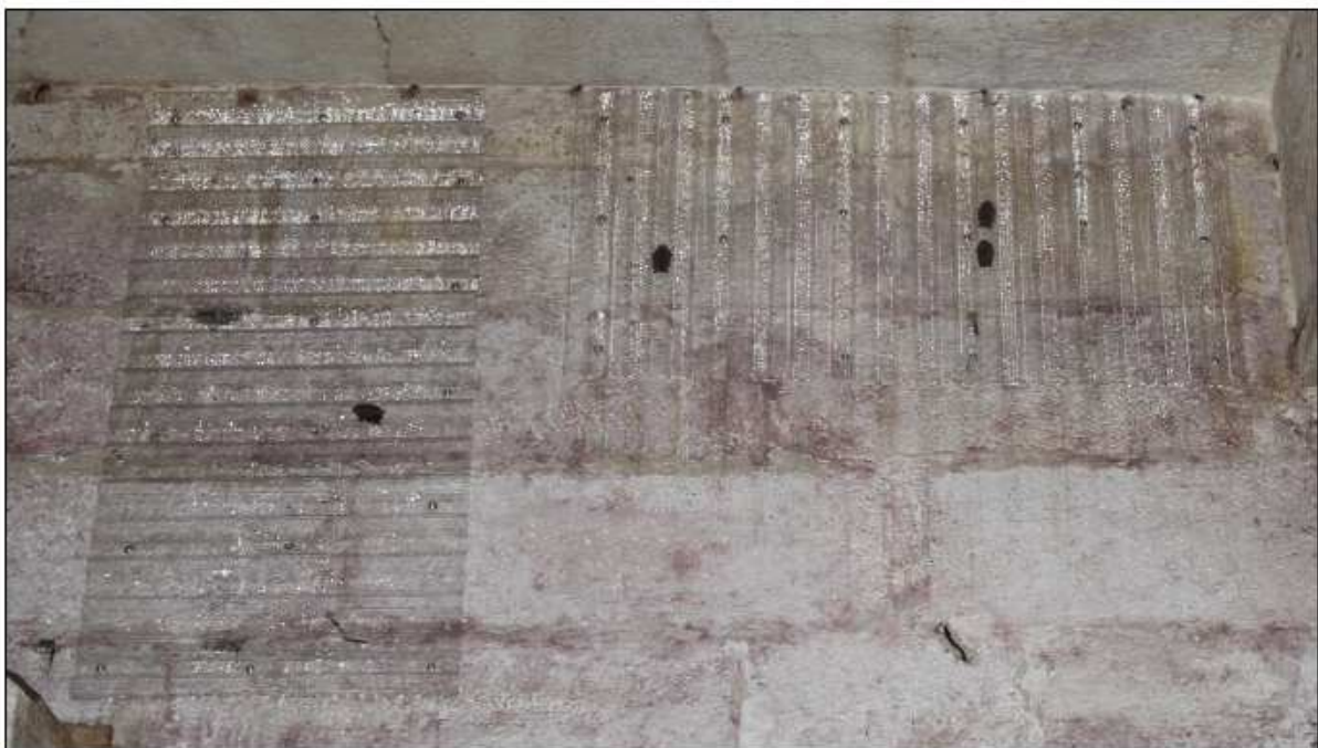
Abbildung 18: Beispiel einer horizontal und einer vertikal an die Wand geschraubte Trapezlichtplatte. Die horizontale Trapezlichtplatte wurde an die Decke angeschlagen, um Zugluft in den Spalten der Trapezlichtplatte zu verringern. In der vertikalen Trapezlichtplatte befindet sich eine und in der horizontalen befinden sich drei überwinternde Fledermäuse (Abb. Matthias Götttsche)
