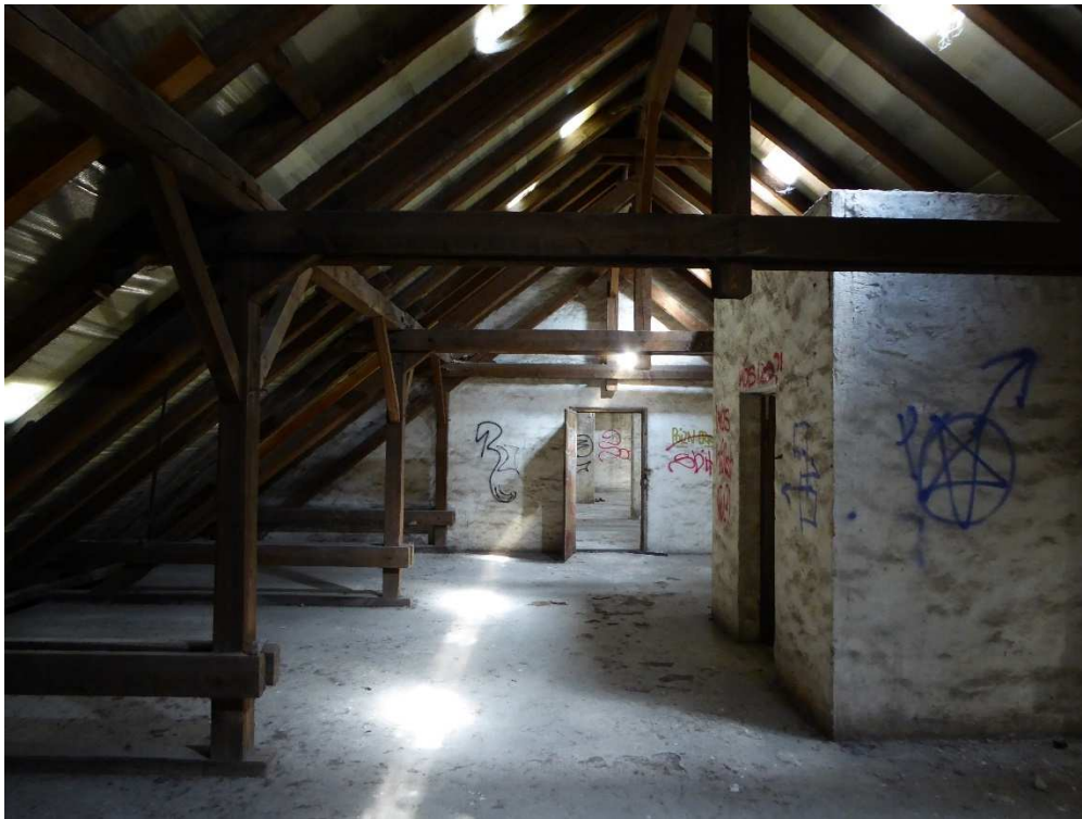
Abbildung 4: Blick auf den Dachboden und die Eindeckung mit Ziegeln und Kunststoff-Unterspannbahnen. Zwischenwände und Kaminzüge bieten Platz für die Anbringung von Fassadenverstecken wie z.B. Fledermaustafeln aus Holz. Zwingend erforderlich ist die Schaffung von Einflügen und eine absolute Abdunklung.
