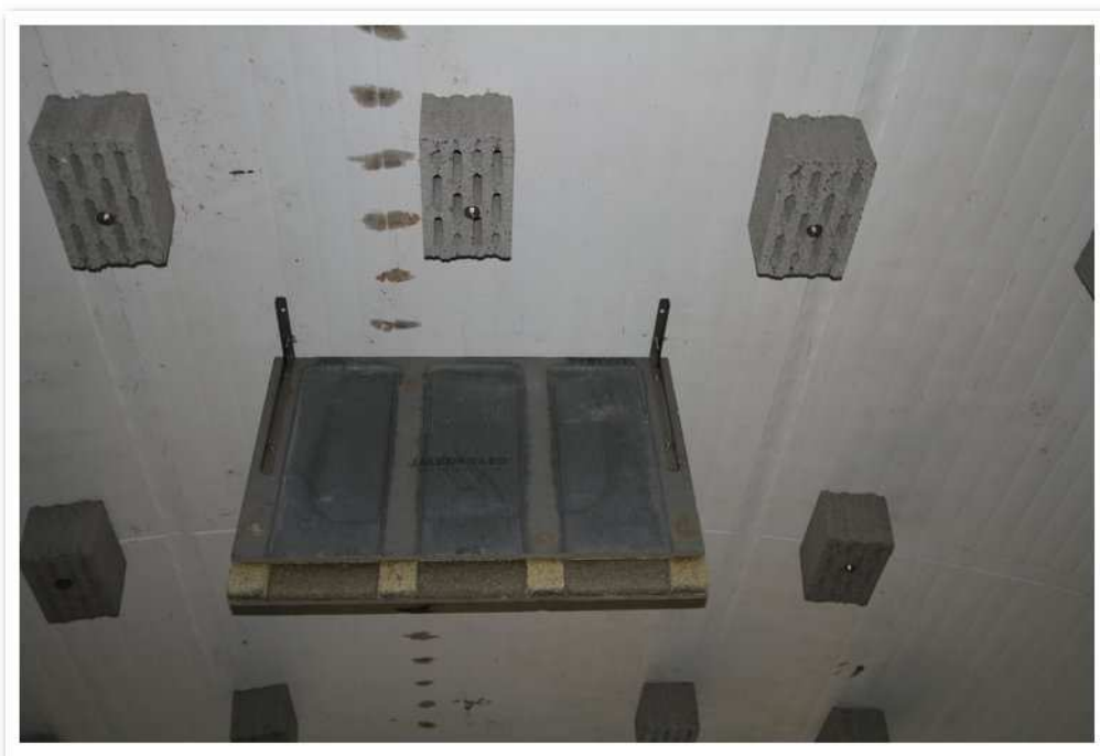
Abbildung 17: Beispiel für montierte Winkler-Betonsteine und ein freihängendes, zweischaliges Fledermaus-Spezialversteck der Fa. Hasselfeldt.
