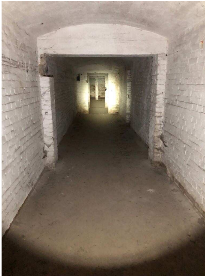
Abbildung 13: Blick in den zentralen Kellergang. Die Deckenhöhe beträgt im gesamten Keller zwischen ca. 2,3 bis 2,4 m
