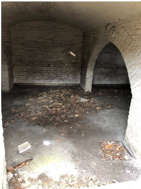
Abbildung 12: Blick in den gewölbten Kellerbereich hinter der Kellertür
