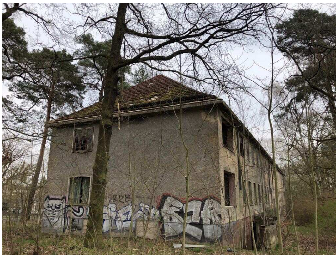
Abbildung 2: Gebäude Nr. 40 mit Blick auf die West- und Südfassade
