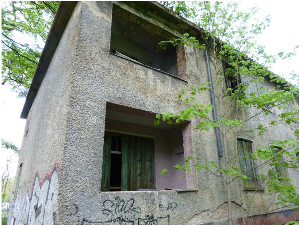
Abbildung 6: An sechs Stellen der Südfassade sind die Fensteröffnungen zurückgesetzt und Balkone eingelassen. Diese Fenster- bzw. Türöffnungen sollen Einflüge in das Gebäudeinnere aufweisen. Die Öffnungen sind so nicht nur witterungsgeschützt, „Höhlungen“ in Fassaden werden auch bevorzugt von Fledermäusen inspiziert, so dass erwartet wird, dass dortige Öffnungen schnell und erfolgreich von den Tieren angenommen werden.
