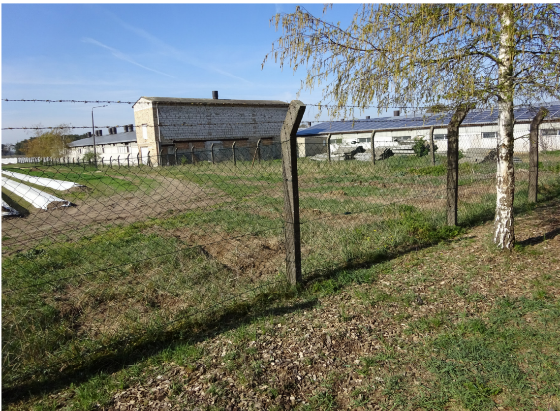
Abbildung 7: Blick auf den für die Regenwasserversickerung vorgesehenen Erweiterungsbe- reich an der östl. Grenze des bestehenden Anlagengeländes, im Hintergrund abzureißendes Verbindungsgebäude am Stall 5
