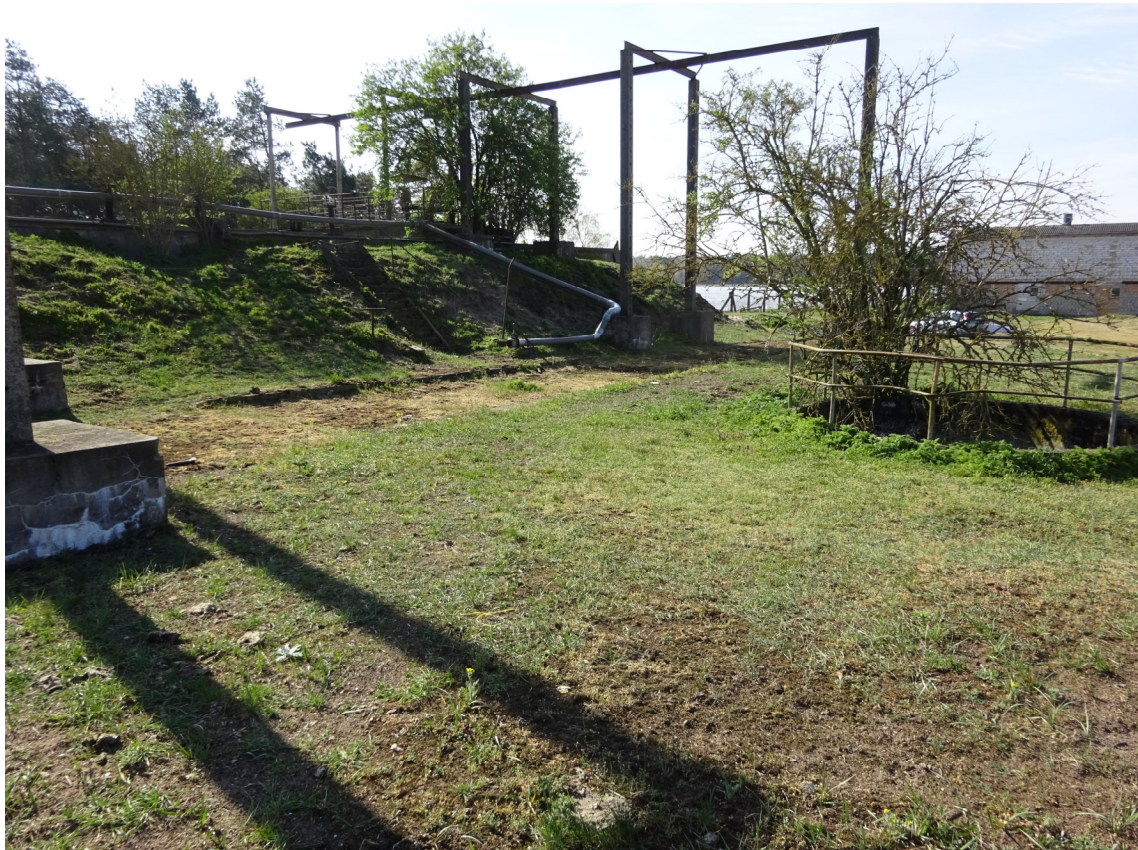
Abbildung 3: Blick aus dem Anlagengelände (im Eingriffsbereich für Stall 11) nach Süden, im Vordergrund die Strukturen im Bereich des abzureißenden Güllebeckens mit Vorgrube, rechts im Hintergrund abzureißendes Verbindungsgebäude am Stall 5
