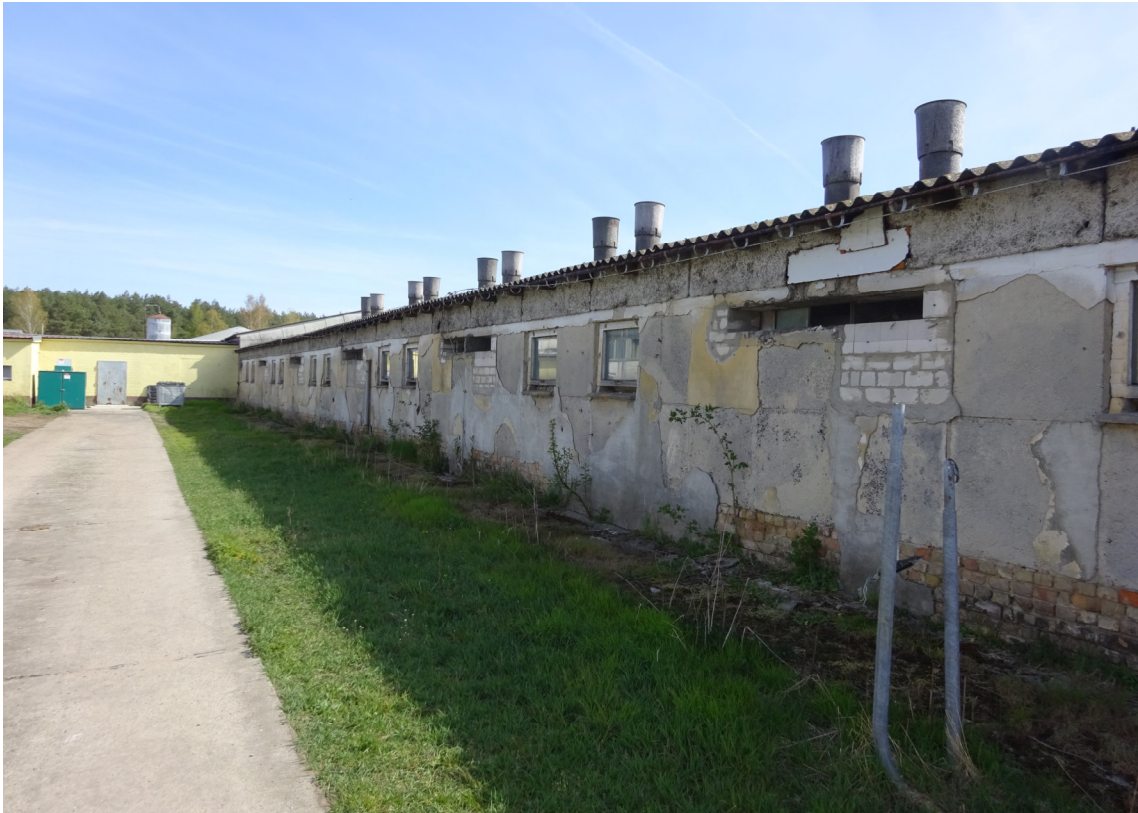
Abbildung 6: Westseite des abzureißenden Stalls 2 mit ebenfalls rückzubauender Umfassung
