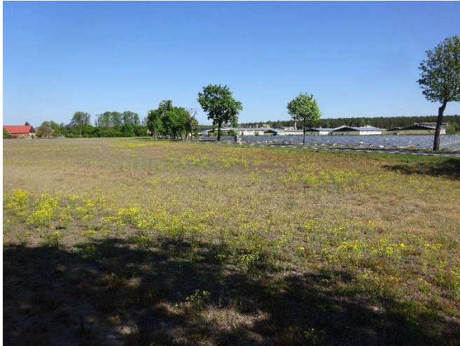
Abbildung 17: Blick auf die Anlage aus Richtung Süd (IBE GmbH, 15.05.2020)
