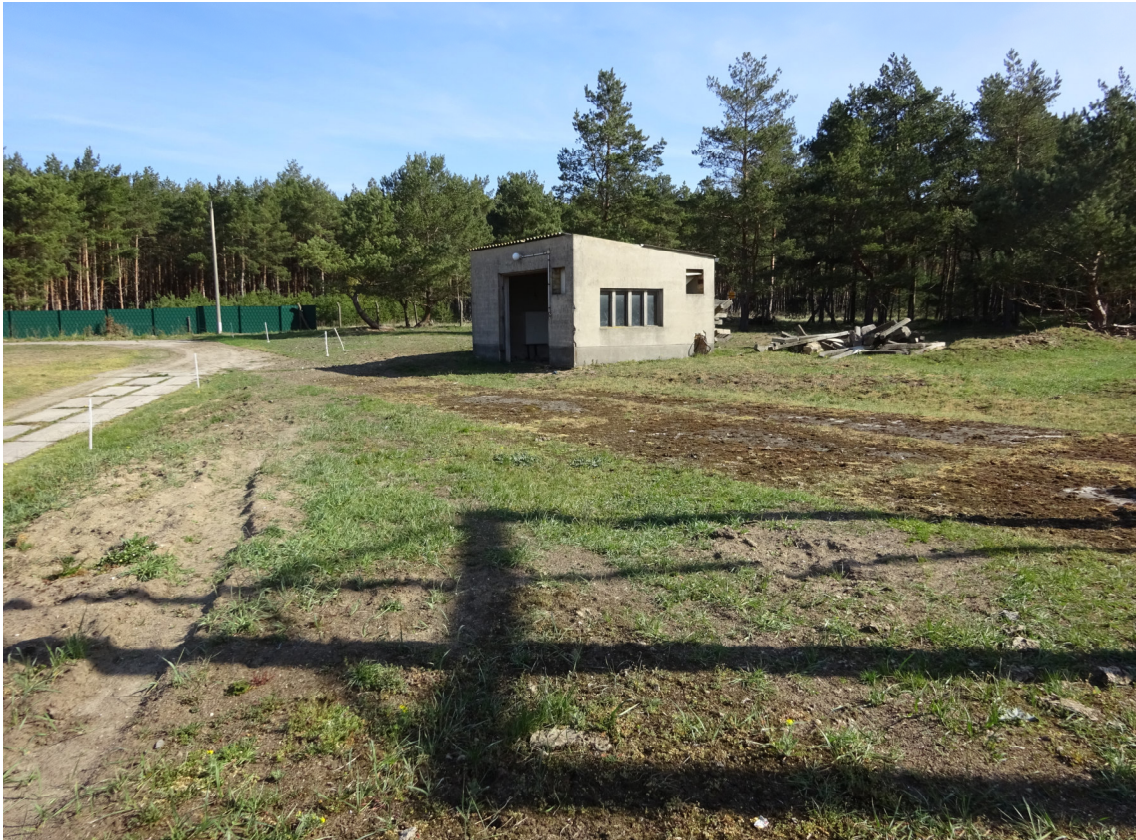
Abbildung 4: Pumpenhaus im Eingriffsbereich am Güllebecken mit ebenfalls rückzubauender Umfahrung
