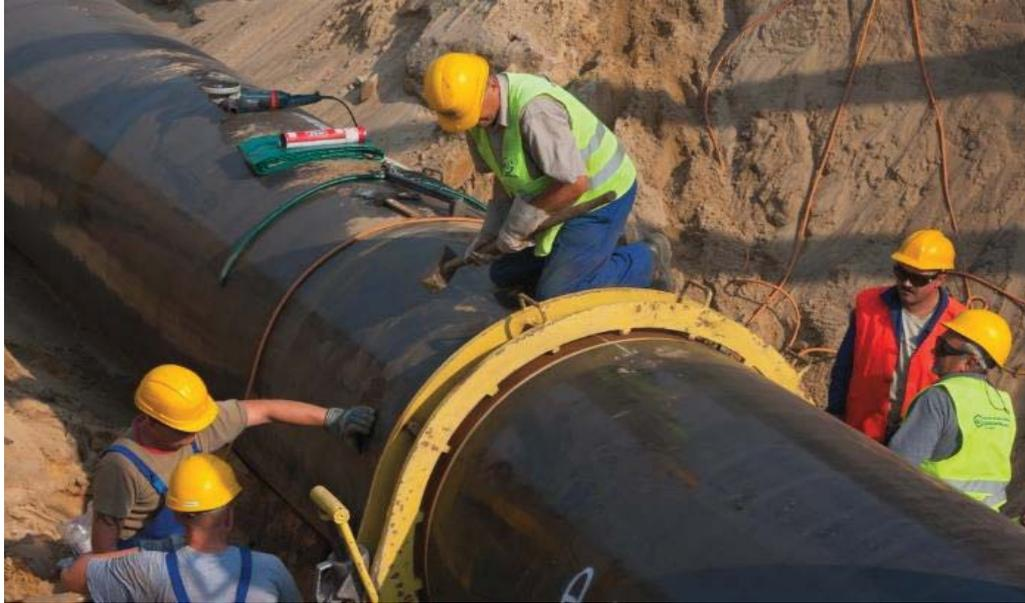
Abbildung 20: Verschweißen der Rohrabschnitte
