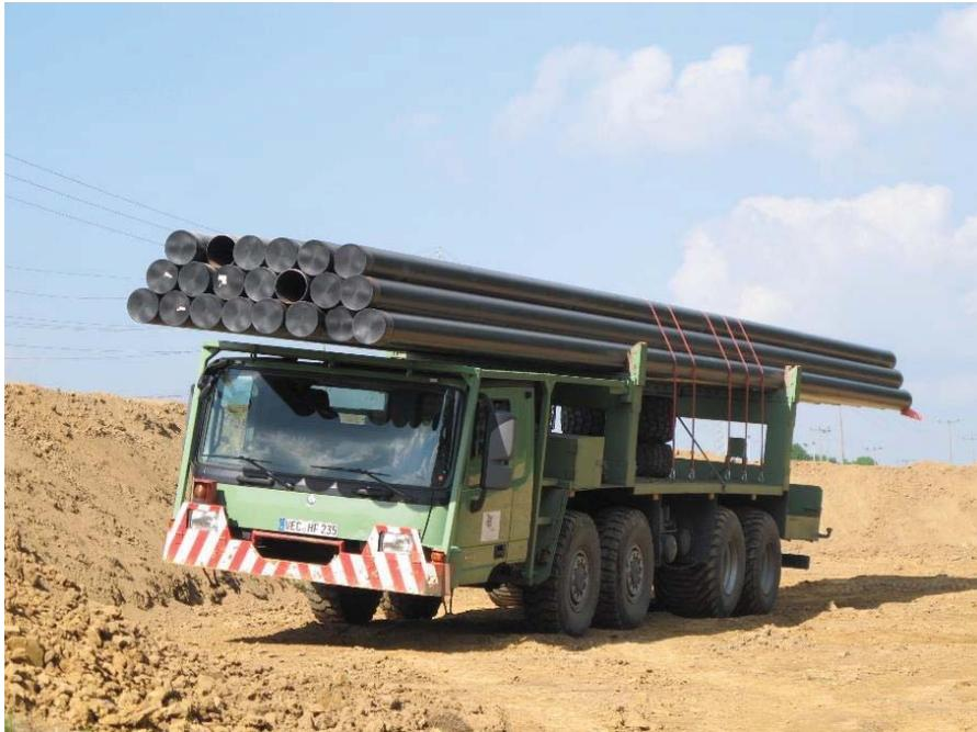
Abbildung 13: Ausfahren der Rohre
