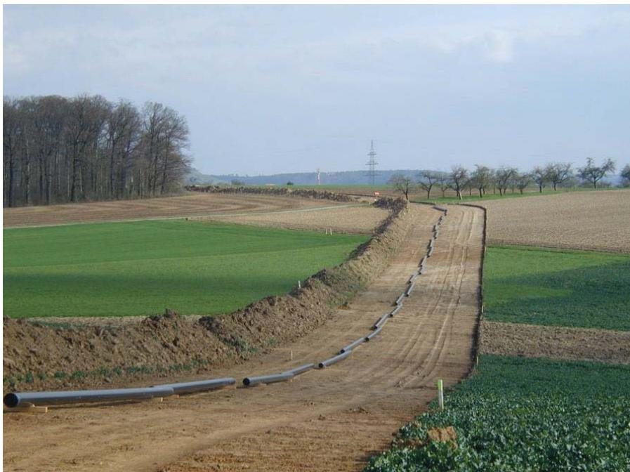
Abbildung 14: Ausfahren der Rohre
