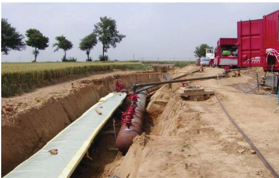
Abbildung 22: Wasserdruckprüfung
