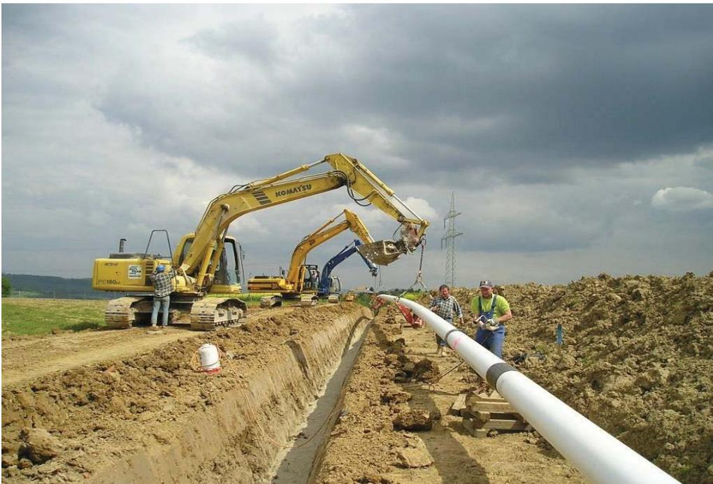
Abbildung 19: Absenken des Rohrstranges
