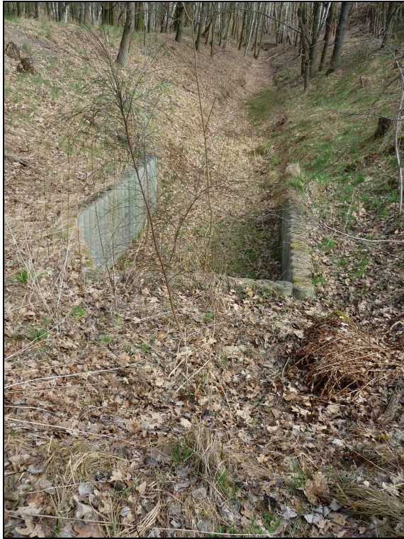
Abbildung 10: Trockener Graben im Teilgebiet 2
