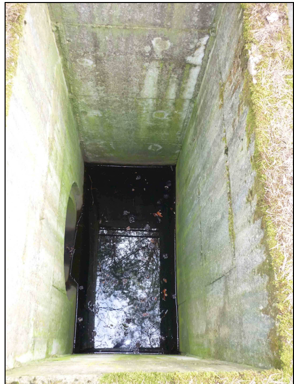
Abbildung 5: Schacht an Gewässer 2
