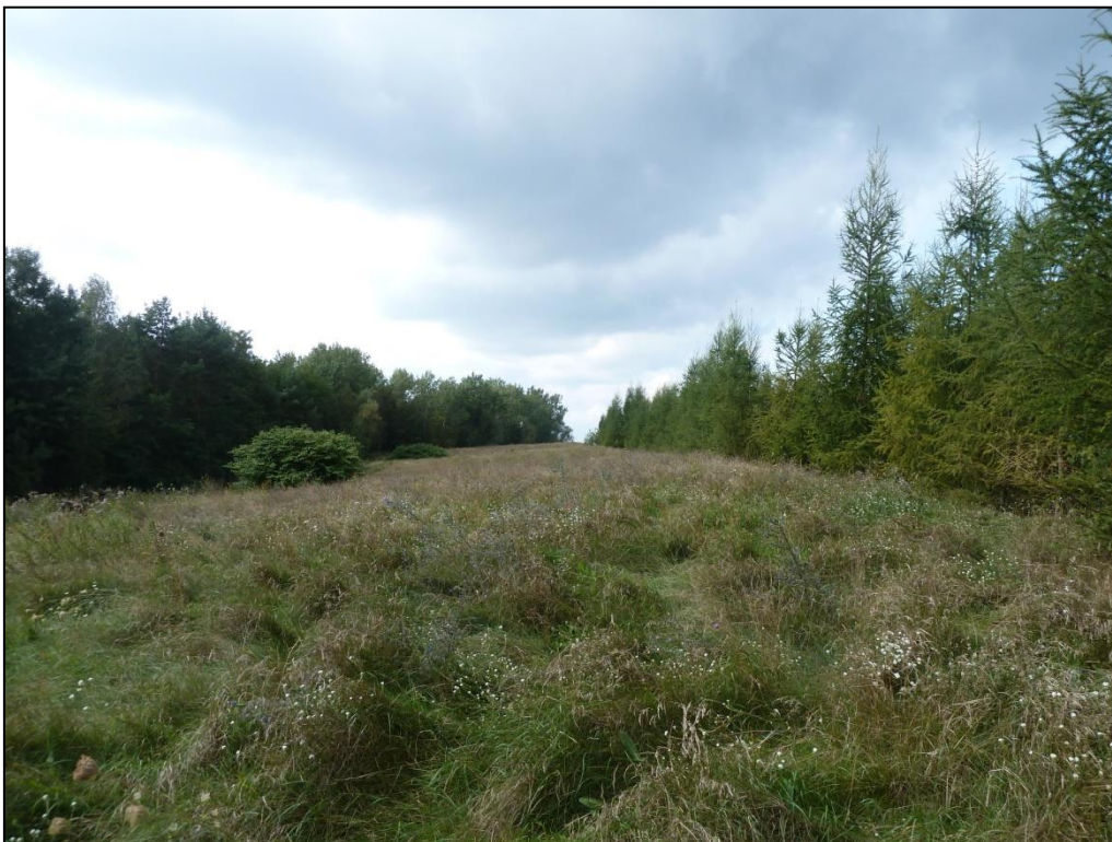
Abb. 23: Deponie im August 2014
