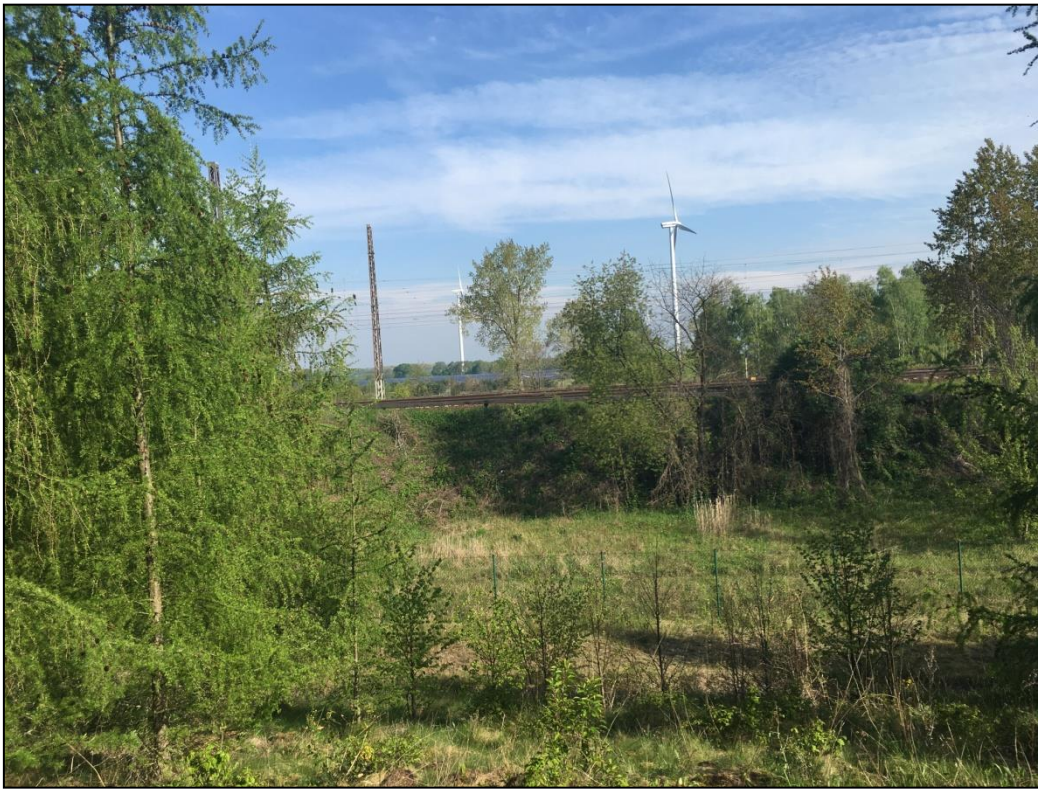
Abb. 21: Bahndamm im nördlichen UR
