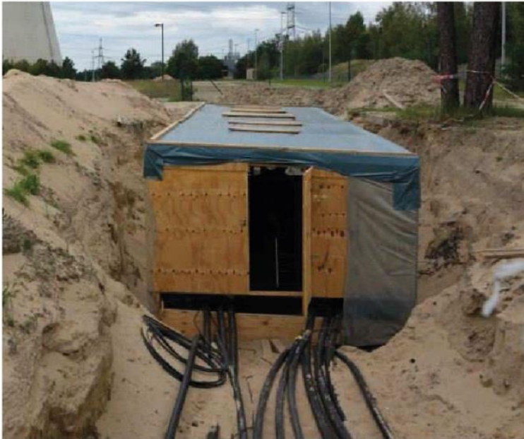
Abbildung 4: Beispiel Einhausung Muffengrube
