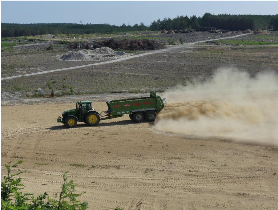
Bild 49: Aufbringen eines reaktiven Teppichs auf die Kippenoberfläche des Tagebaus Welzow-Süd, Bild: LE-B.
