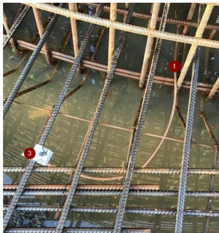
Abbildung 10 Ankerring an Fundamentbewehrung
