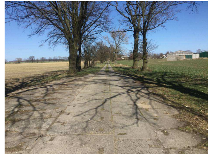
Abb. 5. Mittlerer Abschnitt der geplanten Zuwegung auf Plattenweg westlich Stöffin.
