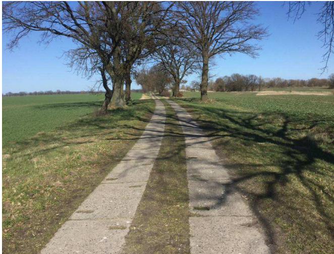
Abb. 6. Östlicher Teil der geplanten Zuwegung.
