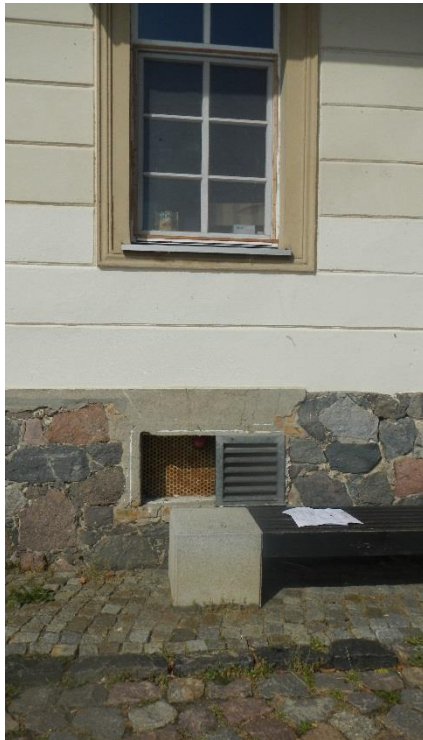
Bild 3 Kelleröffnung, Fenster EG
