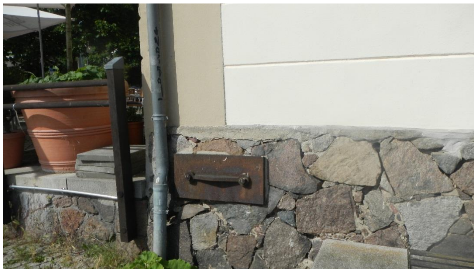
Bild 5 Kelleröffnung mit Lüftung
