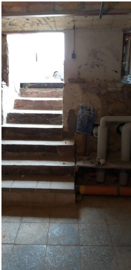
Abbildung 23 Zugang von innen
