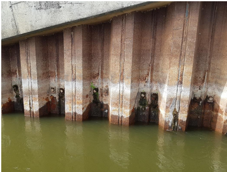
Bild 38 Bewuchs, Abrostungen
