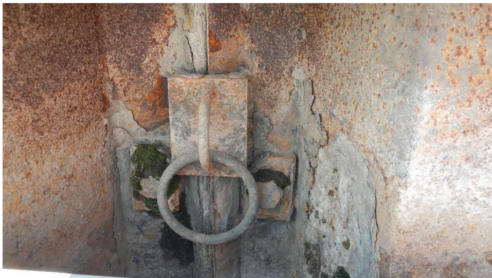
Bild 7 Flächige Korrosion
