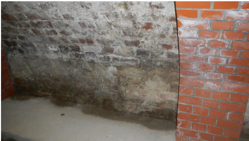
Abbildung 28 Durchfeuchtete Kellerwände
