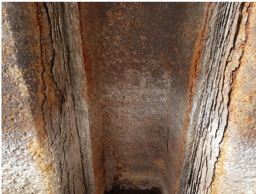
Bild 8 Plattige Abrostungen
