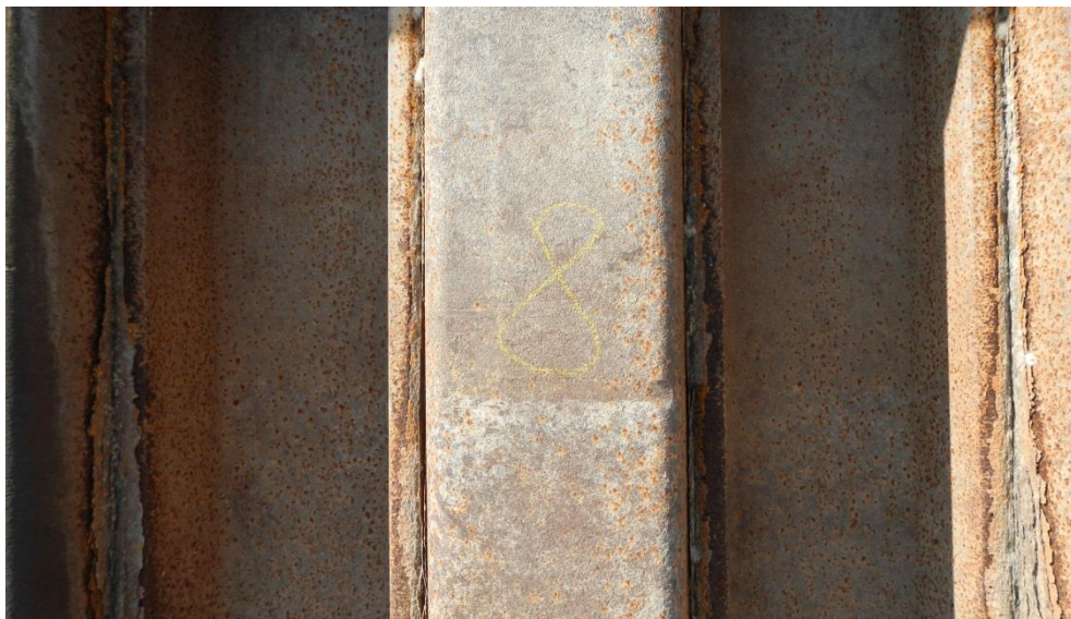
Bild 5 Plattige Abrostungen (links), loser Ankerkopf (rechts)
