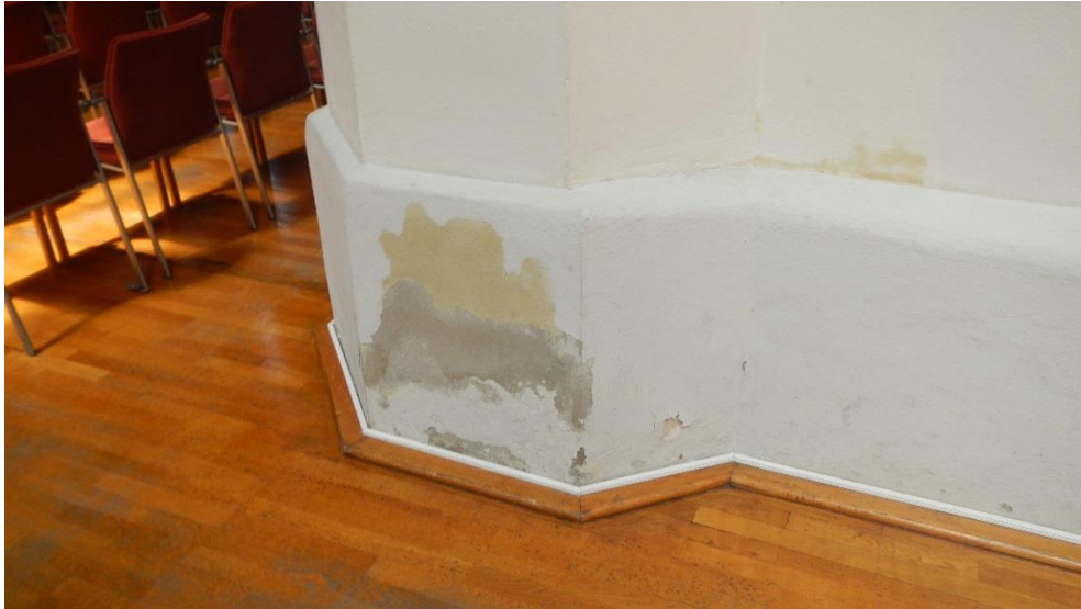
Abbildung 44 Durchfeuchtete Pfeiler
