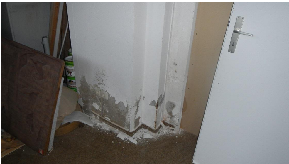
Abbildung 12 Durchfeuchtetes Mauerwerk
