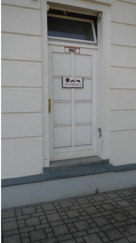
Abbildung 9 Zugang zum Heizraum Gebäuderückseite (HW-sicher)
