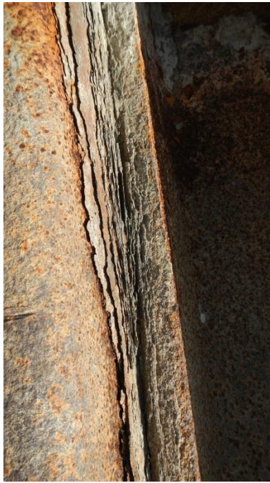
Bild 19 Plattige Abrostungen
