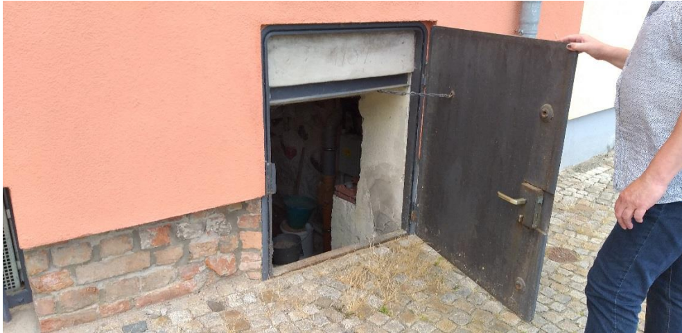
Abbildung 22 Zugang zum Heizungskeller
