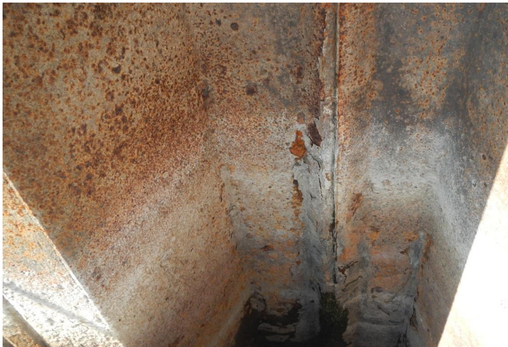
Bild 34 Rostschäden, Abplatzungen
