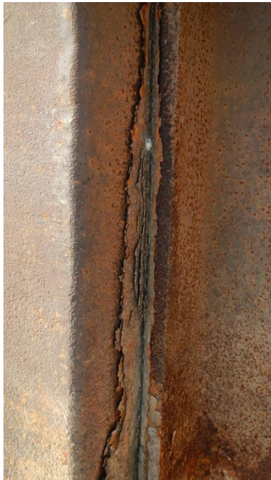
Bild 5 Plattige Abrostungen (links), loser Ankerkopf (rechts)
