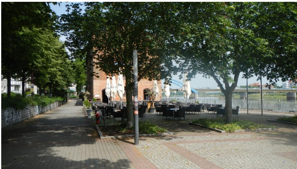
Abbildung 29 Ansicht Oderspeicher Südseite
