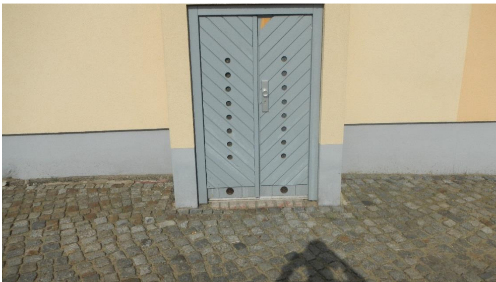
Abbildung 18 Eingang zum Gewölbekeller
