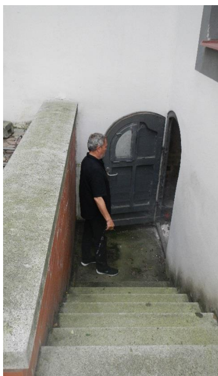
Bild 4 Zugang zu Gewölbekeller (Hofseite)
