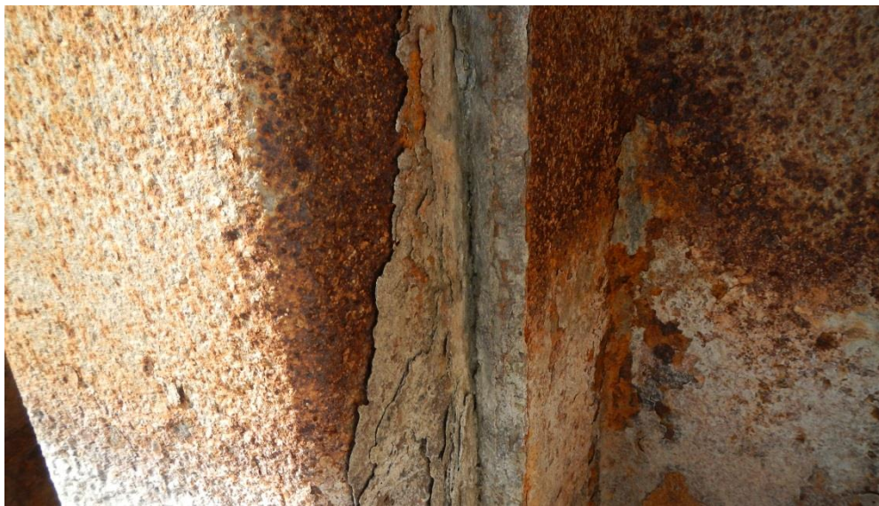
Bild 15 Lose Ankerplatten
