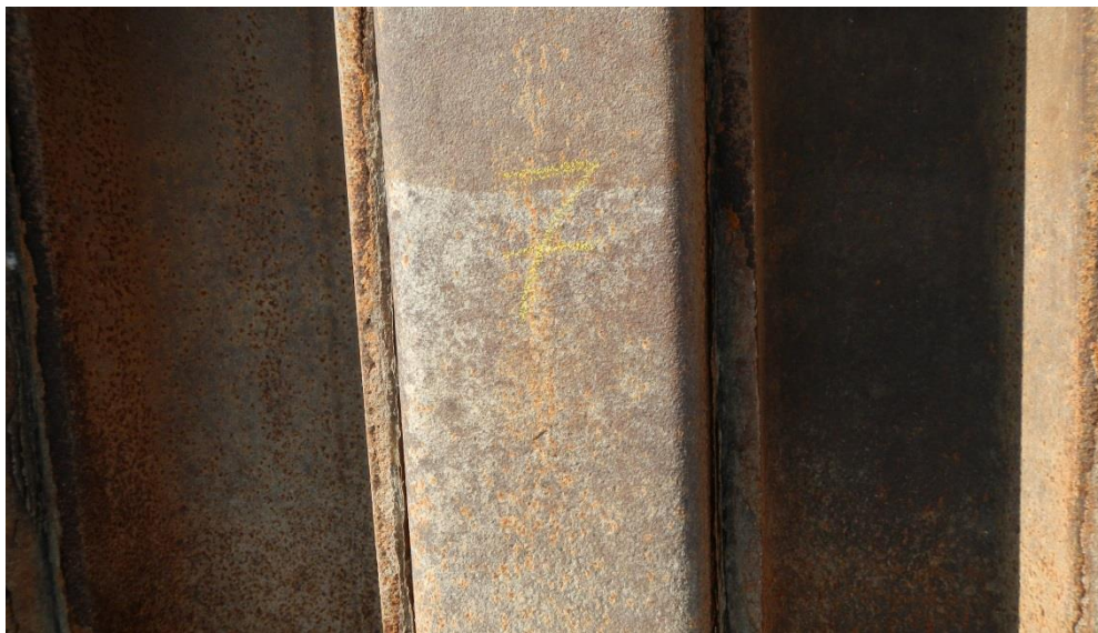
Bild 1 Beginn Sichtkontrolle Abschnitt 1 Messpunkt 7
