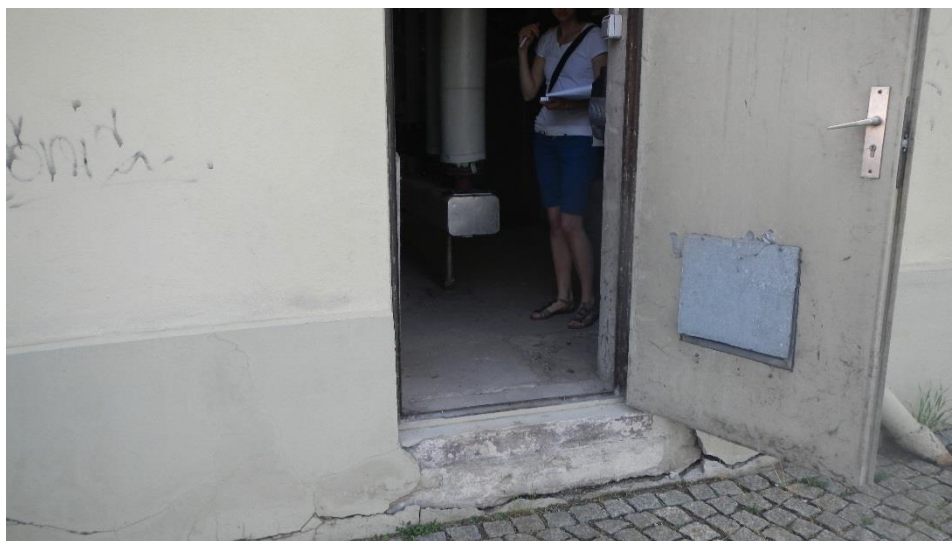
Bild 1 Eingang Gebäuderückseite (keine Maßnahmen erforderlich)
