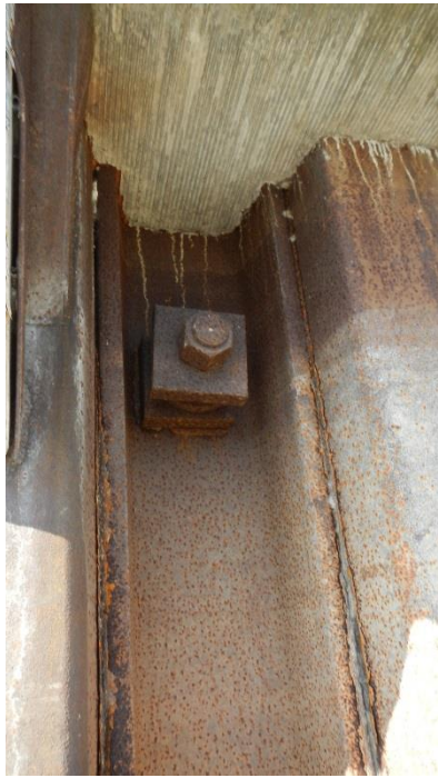
Bild 15 Lose Ankerplatten
