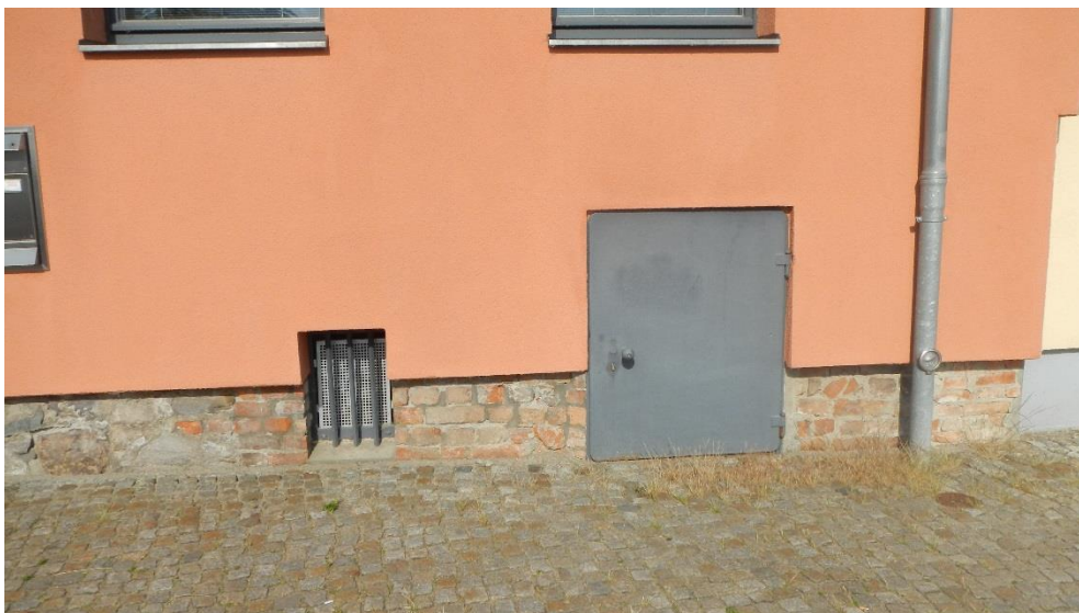
Abbildung 21 Kellerluke und Zugang zum Heizungskeller
