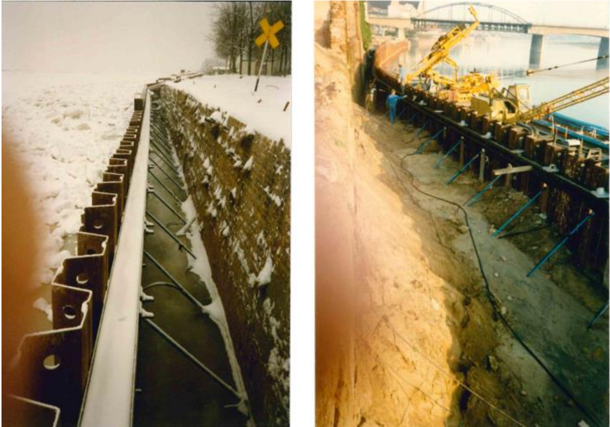
Abbildung 6: Verankerung im Abschnitt 3 bis 5
