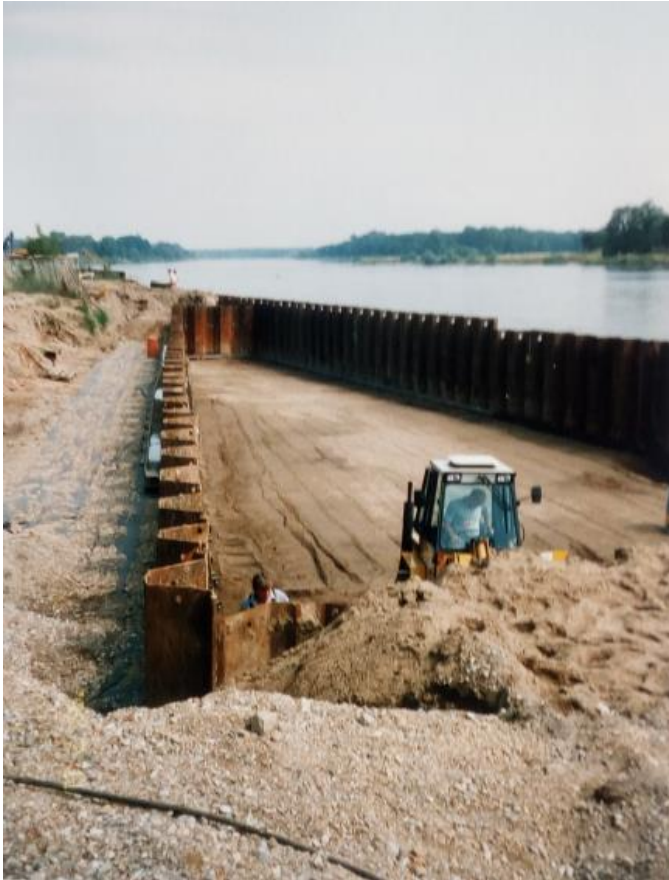
Abbildung 15: Stahlspundwandkasten Römertreppe
