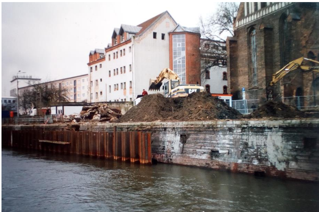
Abbildung 12: Bau Ufermauer Abschnitt 2
