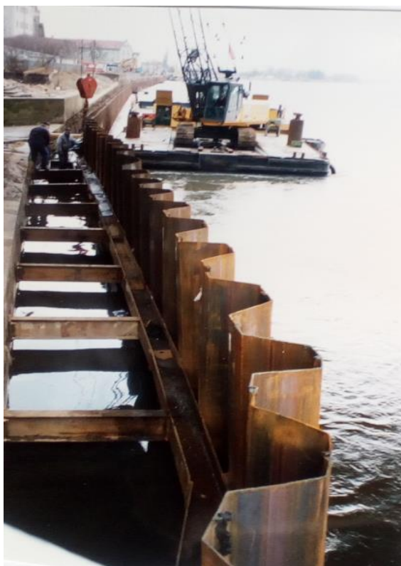
Abbildung 13: Bau Ufermauer Abschnitt 2
