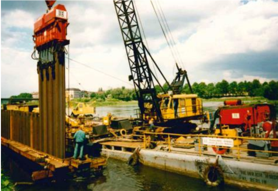
Abbildung 5: hydraulisches Einpressen der Spundbohlen im Abschnitt 3 bis 5
