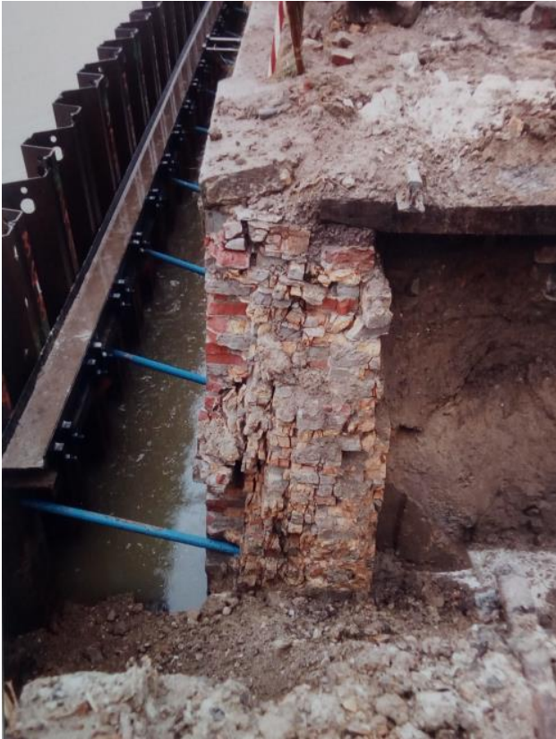
Abbildung 14: Bau Ufermauer Abschnitt 2
