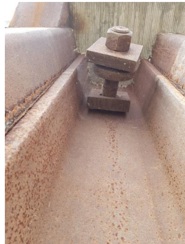
Abbildung 3: Spundwand, herunterhängende, vermutlich gelöste Ankerköpfe
