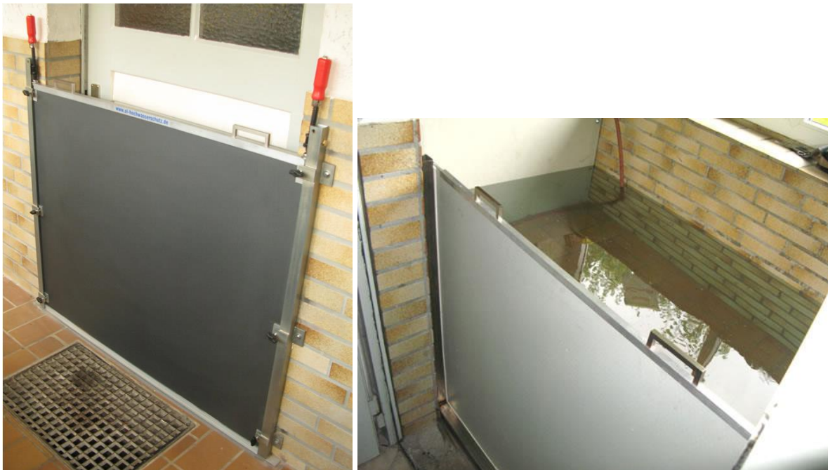
Abbildung 26: Dammtafeln vor Hauseingang (Quelle http://www.al-hochwasserschutz.de/dammtafeln.html )
