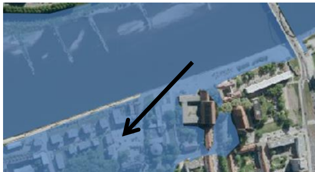
Abbildung 4: Überflutungsfläche nördlich der Stadtbrücke
