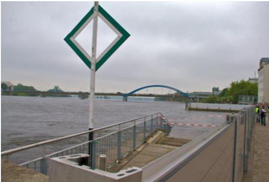
Abbildung 1: mobiles System zum Oderhochwasser 2010
