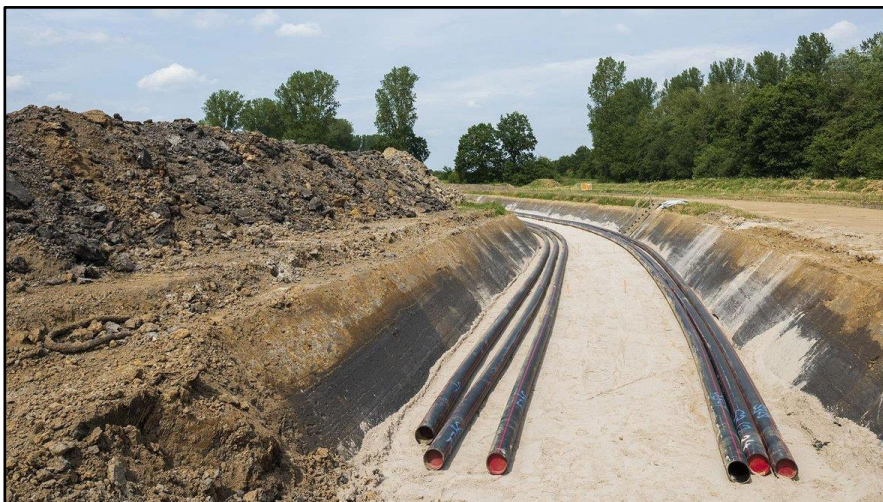
Abb. 9: Kabeltrasse mit Bettung und Schutzrohr (Beispiel)
