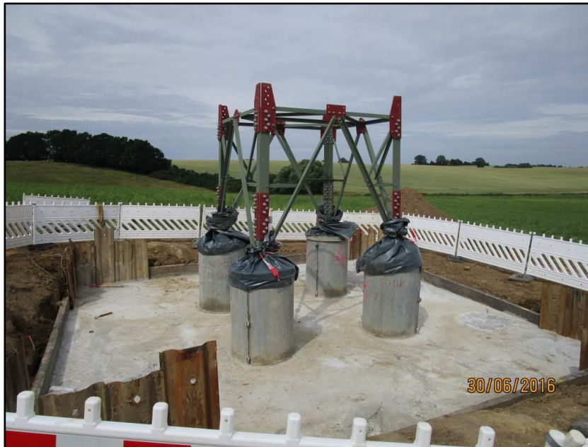
Abb. 10: Baugrube mit Fundament (Beispiel)
