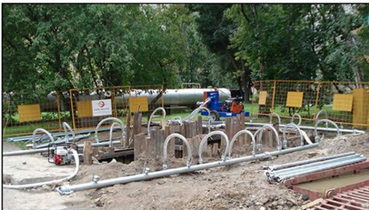
Abb. 1 Praxisbeispiel für geschlossene Wasserhaltung mit Vakuum-Filterlanzen betrieben mit einem Dieselpumpaggregat
