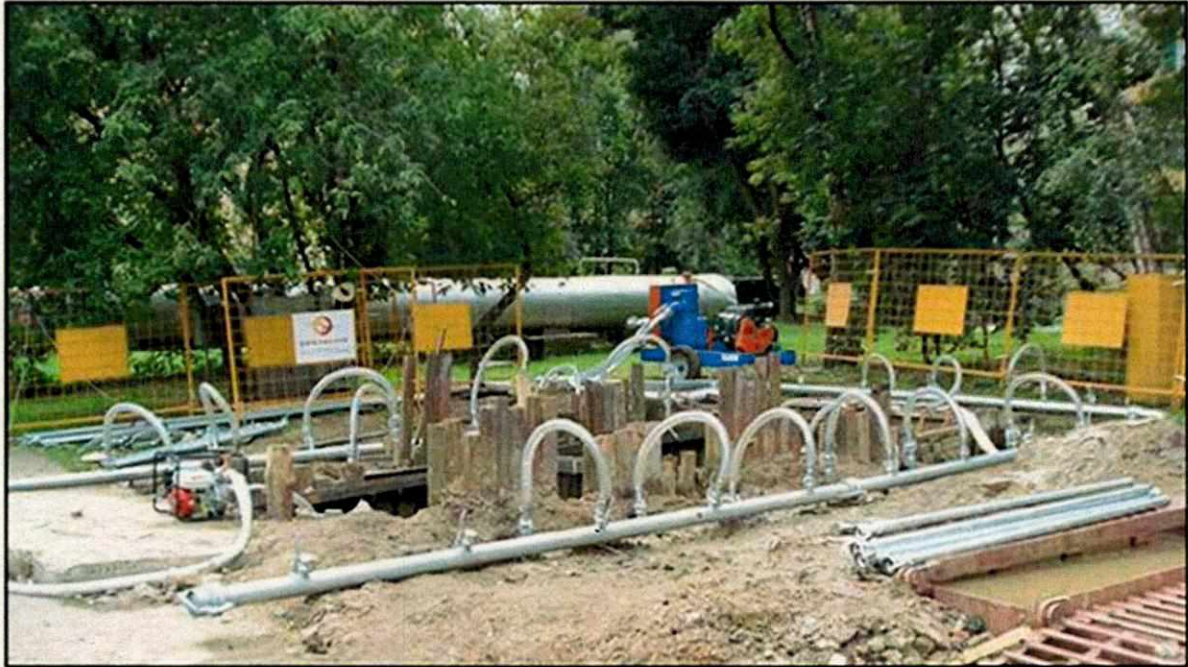
Abb. 1 Praxisbeispiel für geschlossene Wasserhaltung mit Vakuumpumpen betrieben mit einem Dieselpumpaggregat
