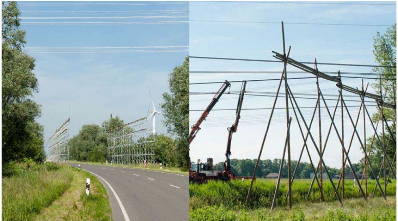
Abb. 35 - Beispiele für Schutzgerüste aus Stahl bzw. Holz
