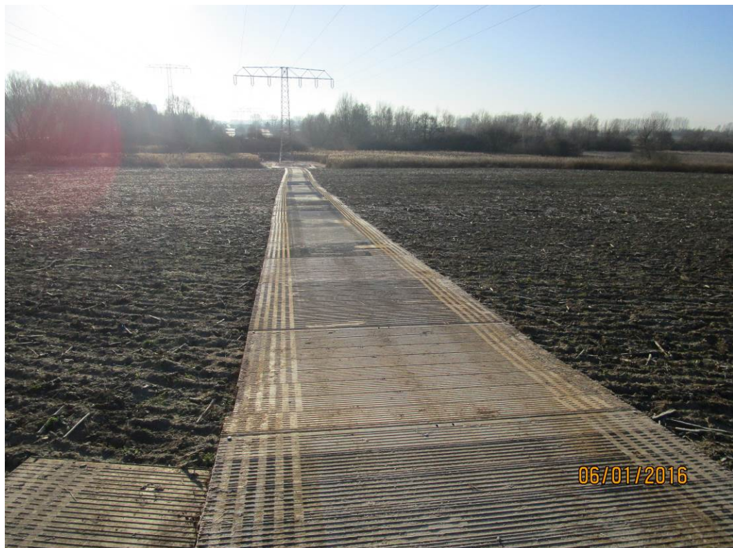
Abb. 29 - Beispiel einer Baustraße mit Matten (Beispiel)
