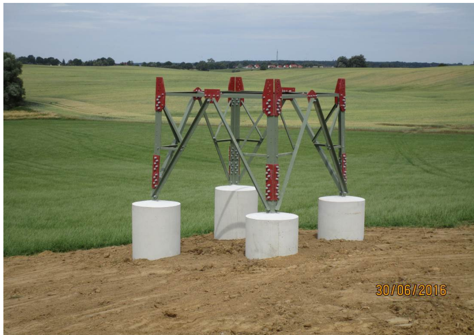
Abb. 27 - Beispiel eines wiederverfüllten Plattenfundamentes (Beispiel)
