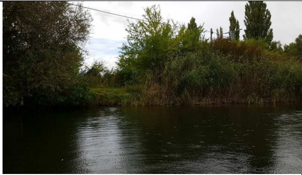
Abbildung 9: Lage Durchlass 2, Eichlerstich
