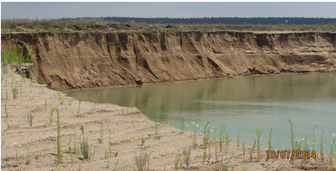
Abb. 3: Steil stehende Gewinnungsböschung über Wasser
