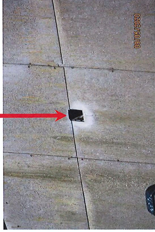
Abb. 15. Turmfalkenbrutplatz (56) in landwirtschaftlichem Gebäude in Stöffin.
