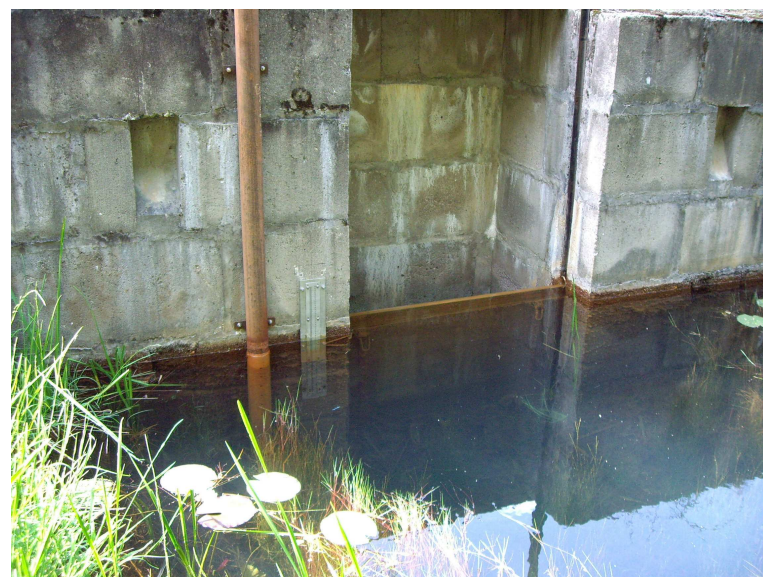
Abflusspegel MP 1 Erlenteichgraben, Rehbockwehr
