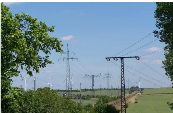
Abb. 38: Eisenbahntrasse und Hochspannungsleitungen, Fotostandort 51, Blick nach NO
