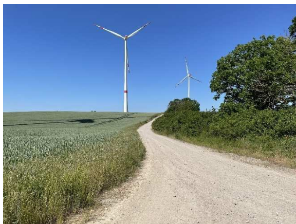
Abb. 3: vorhandene Zufahrt zu den Bestandsanlagen - Abzweig vom Weg zwischen der B2 und Mürow
