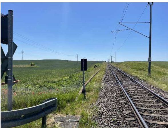
Abb. 44: Eisenbahntrasse und Hochspannungsleitungen, Fotostandort 48, Blick nach SW
