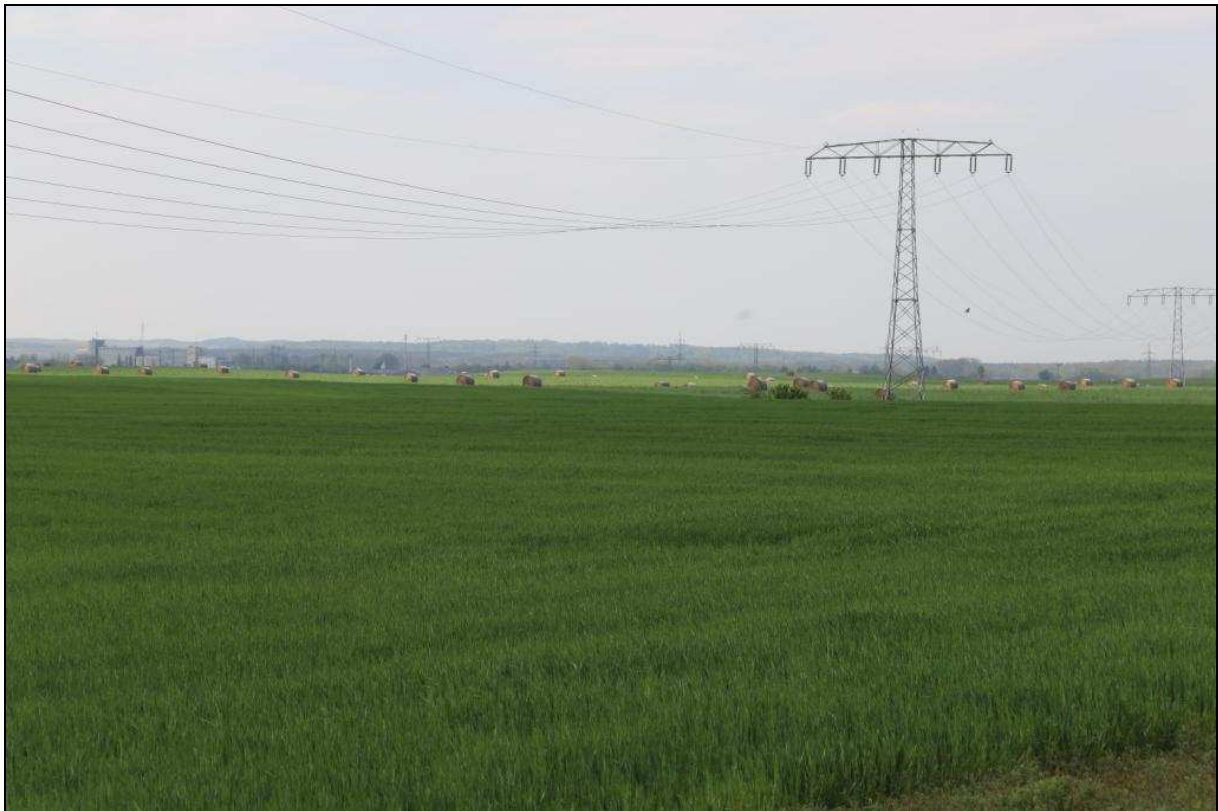
Abb. 1: Vorhabensgebiet im April 2020
