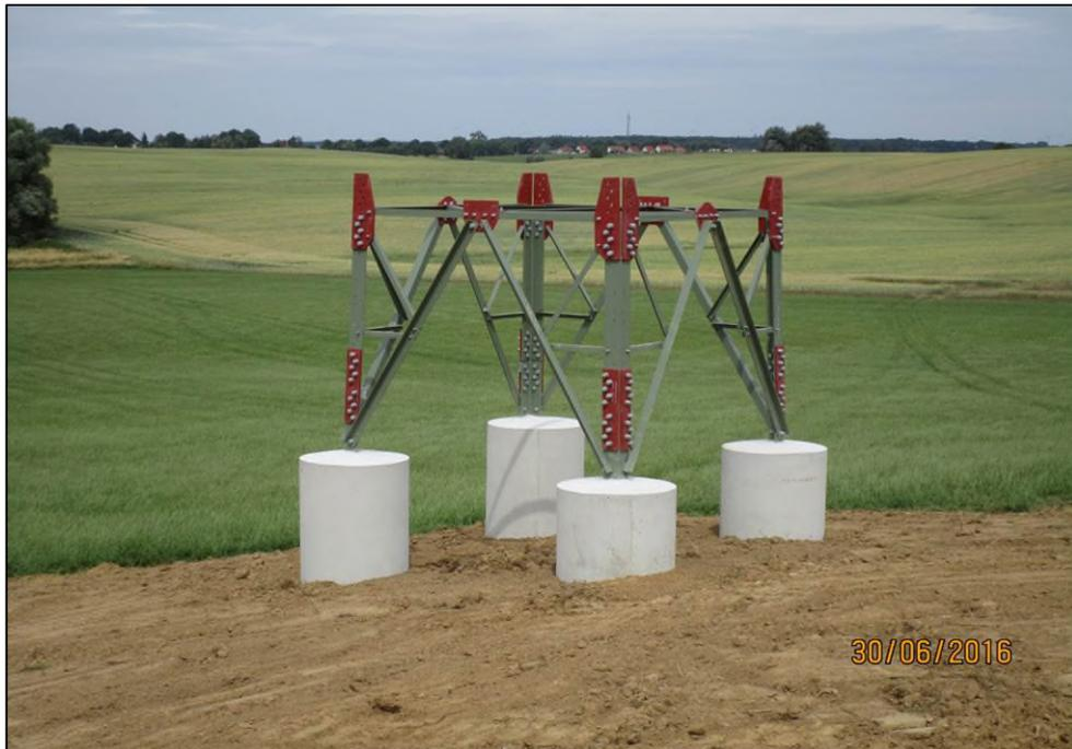
Abb. 11 - Beispiel eines wiederverfüllten Plattenfundamentes, Quelle: LTB Leitungsbau GmbH 2016
