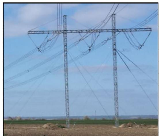
Abb. 13 - Einebenenprovisorium (Variante Tragprovisorium), Quelle: Omexom 2020, LTB Leitungsbau GmbH o.J.
