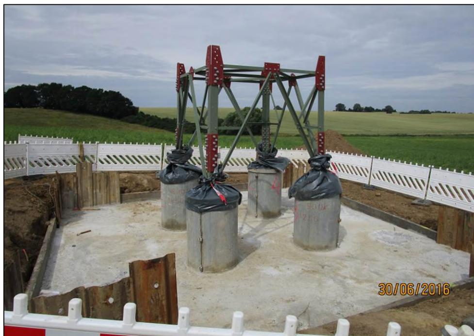
Abb. 15 - Beispiel einer Baugrube mit Fundament, Quelle: LTB Leitungsbau GmbH 2016
