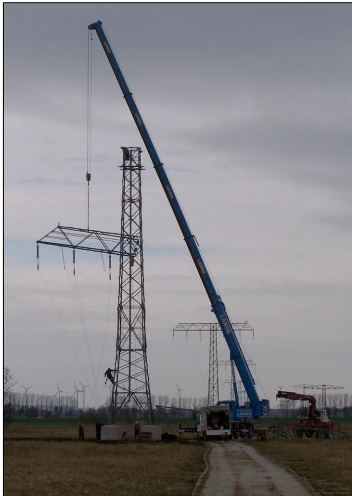
Abb. 16 - Maststellen mittels Autokran (Beispiel), Quelle: LTB Leitungsbau GmbH o.J.
