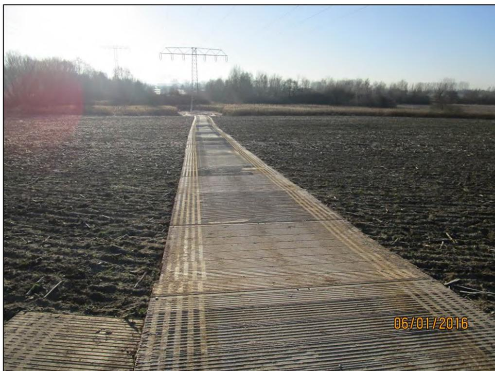
Abb. 12 - Beispiel einer mit Matten ausgelegten temporären Baustraße, Quelle: LTB Leitungsbau GmbH 2016
