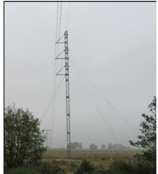
Abb. 14 - Einstielprovisorium (Variante Tragprovisorium), Quelle: Omexom 2020, LTB Leitungsbau GmbH o.J.
