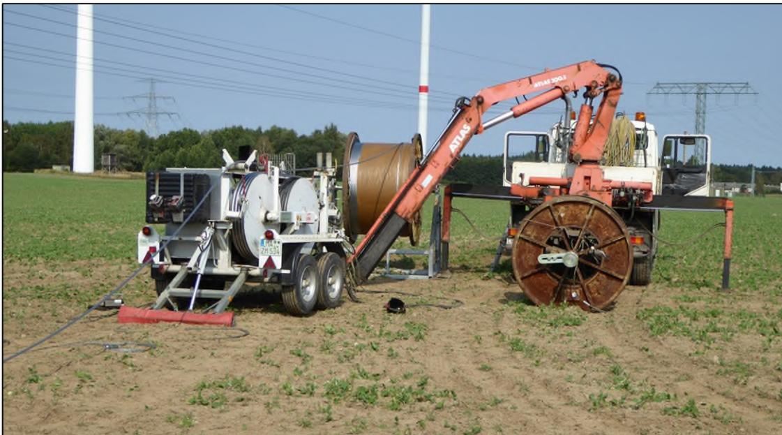
Abb. 17 - Aufstellplatz für Seiltrommel (Beispiel), Quelle: LTB Leitungsbau GmbH o.J.
