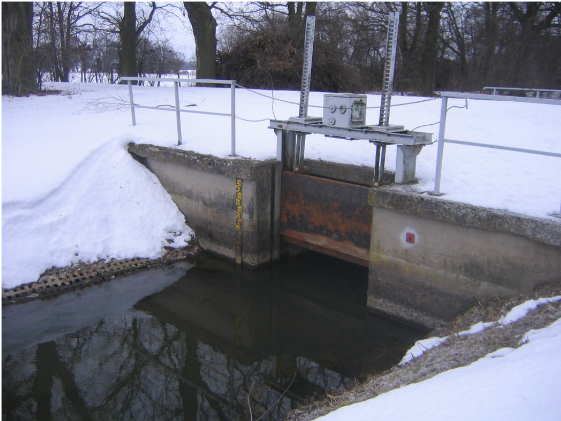
Foto 1: Stauwehr bei Hermannshof (mit Lattenpegel) am 8.02.2010. Das Wehr war gezogen (freier Ablauf).
