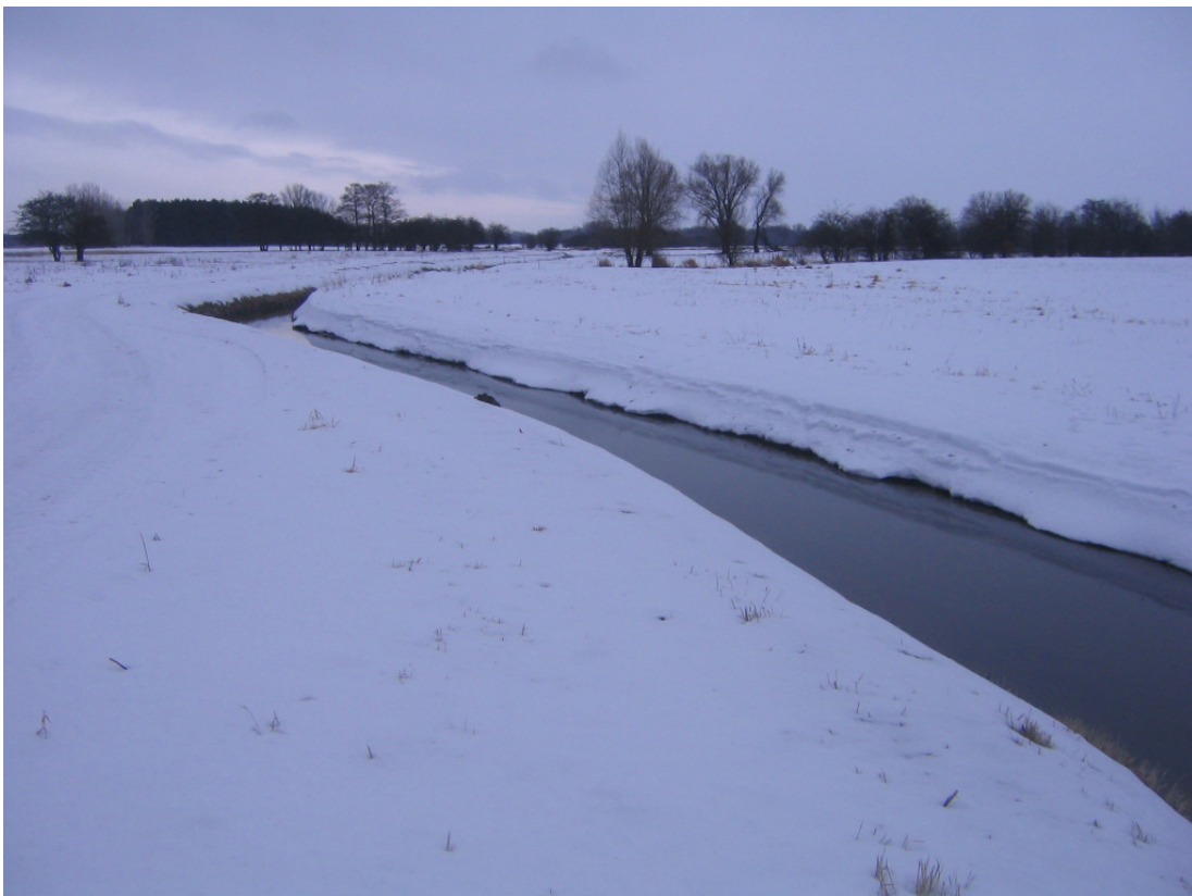
Foto 2: Wittenberger Hauptabzugsgraben am Stauwehr Hermannshof (Blickrichtung Südosten). Bei offenem Wehr wirkt der Graben als Vorfluter.
