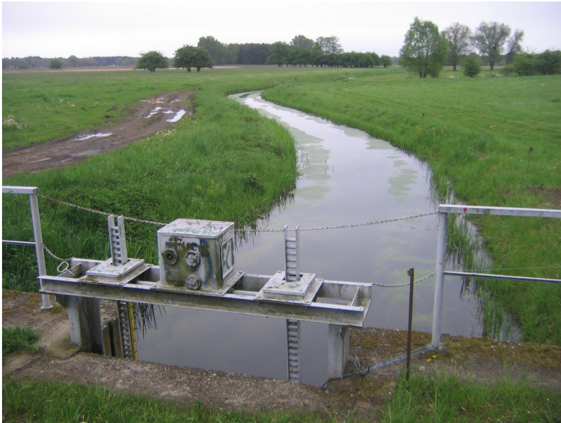
Foto 5: WHAG am Stauwehr Hermannshof (Blickrichtung Südosten) am 15.05.2005 bei geschlossenem Wehr. Das Wasser steht im Graben fast geländegleich.
