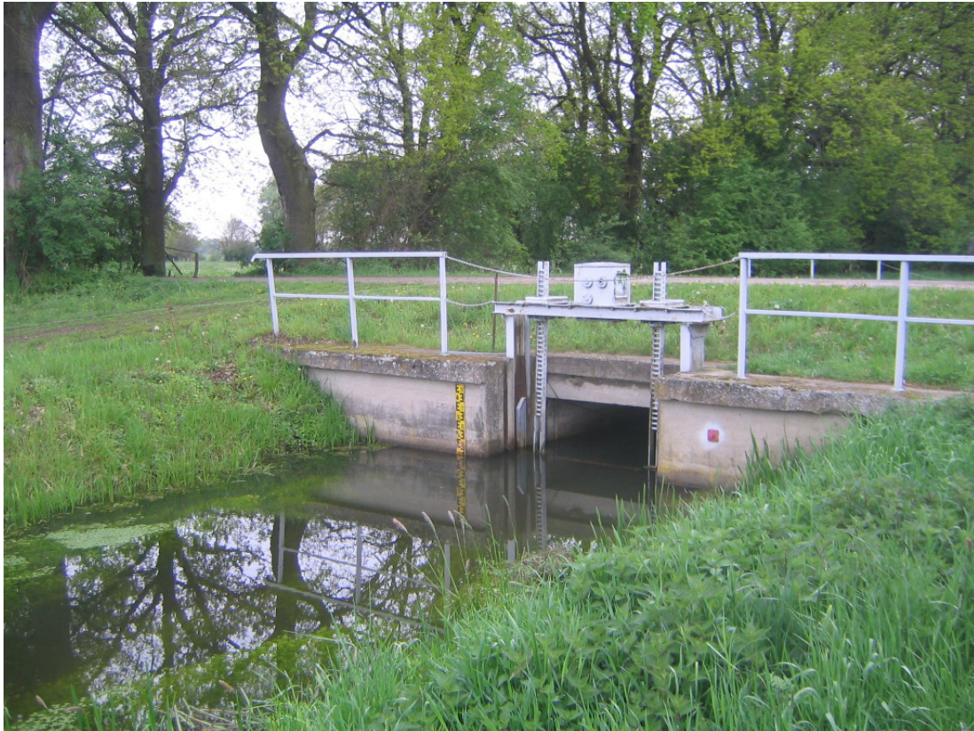
Foto 3: Stauwehr bei Hermannshof am 15.05.2010. Das Foto belegt eine „Wasserüberschuß-Situation“ im Untersuchungsraum. Das Wehr ist gesetzt und wird auf einer Höhe von 20 cm überströmt (WSP 18,70 m NN).
