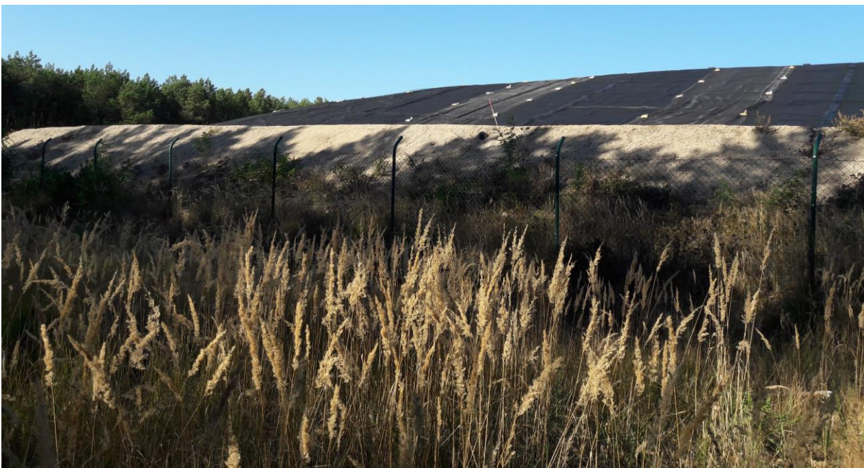
Abbildung 10: Biotopnummer 02, bestehende Deponie tlw. mit schwarzer Abdeckfolie abgedeckt, im Bereich des Zaunes ist die Spontanvegetation auf Sekundärstandorten, von Gräsern dominierte Bestände; weitgehend ohne Gehölzbewuchs (Biotopnummer 03) zu erkennen (Quelle: Arcadis Germany GmbH, Stand 11.10.2019)
