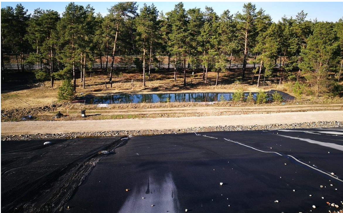
Abbildung 7: Deponiekörper der Schüttbereiches II, gesichert mit schwarzer Folie (Quelle: aspn, Datum 20.03.2019)
