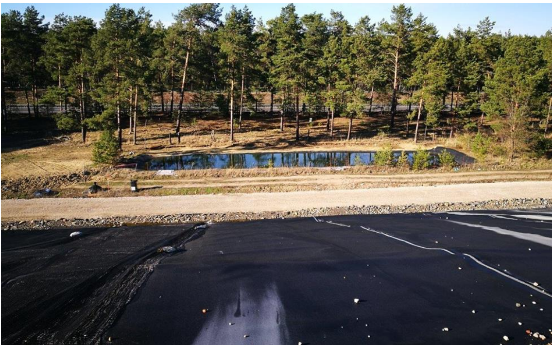
Abbildung 7: Deponiekörper des Schüttbereiches II (Blick nach Norden auf die Autobahn A 15), dieser ist abschnittsweise bereits mit Folie gesichert (Quelle: ASPN-Eigenbetrieb; Datum 20.03.2019)
