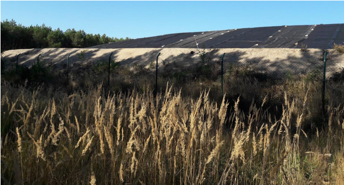
Abbildung 8: bestehende Deponie teilweise mit einer Zwischenabdeckung abgedeckt (Quelle: Arcadis Germany GmbH, Stand 11.10.2019)
