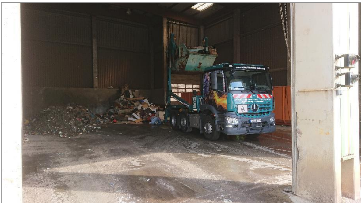
Abbildung 9: Umladebereich der Abfallumschlagstation
