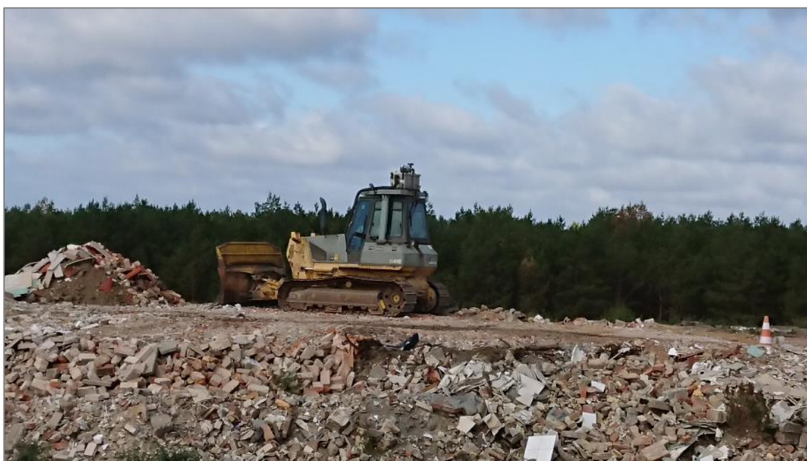
Abbildung 6: Deponiekörper – Schüttbereich II mit Raupe
