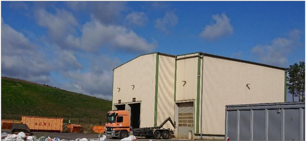
Abbildung 8: Abfallumschlagstation – Ansicht aus Südost
