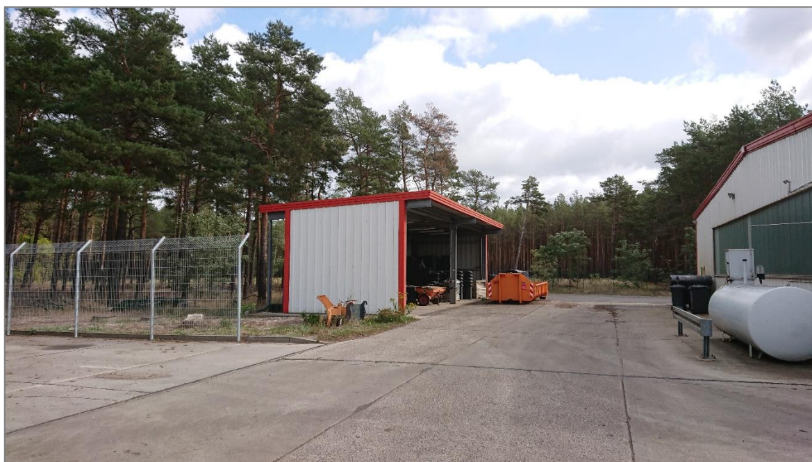
Abbildung 10: Waschplatz und Tankstelle mit Werkstattgebäude
