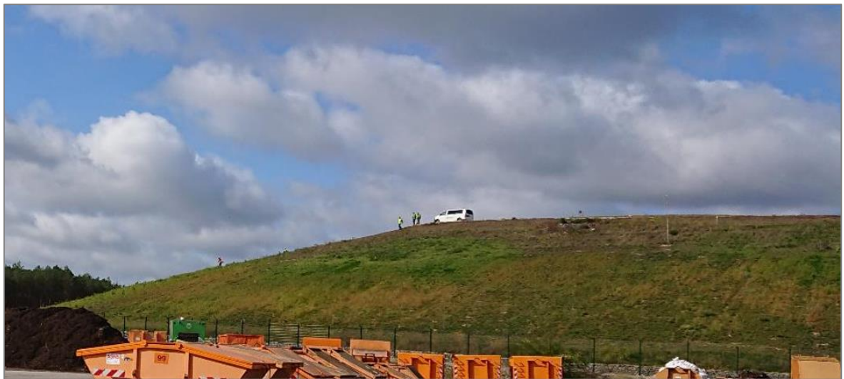
Abbildung 3: Deponiekörper – Schüttbereich I
